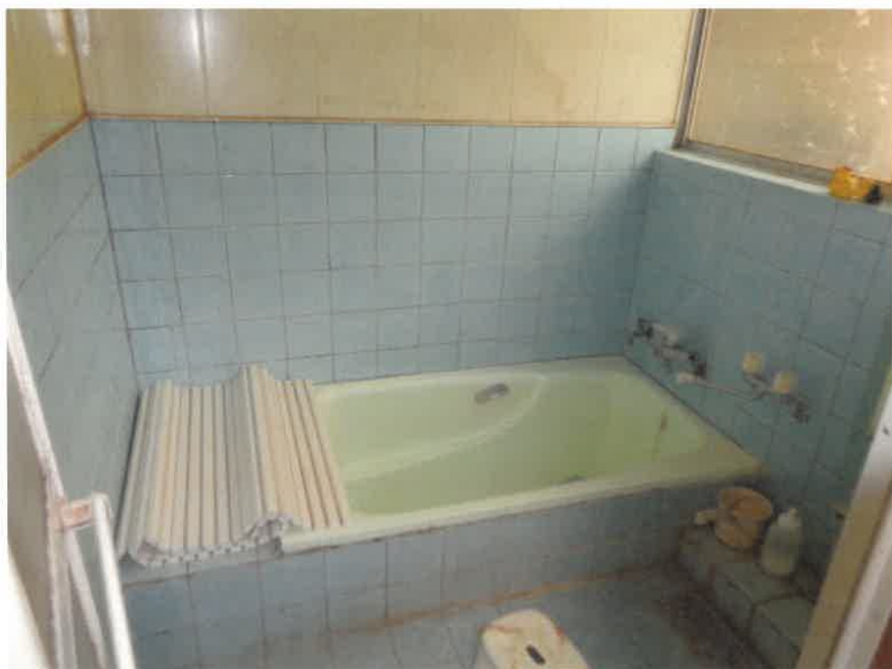
(写真 1 5) 物件 3 の建物内部
