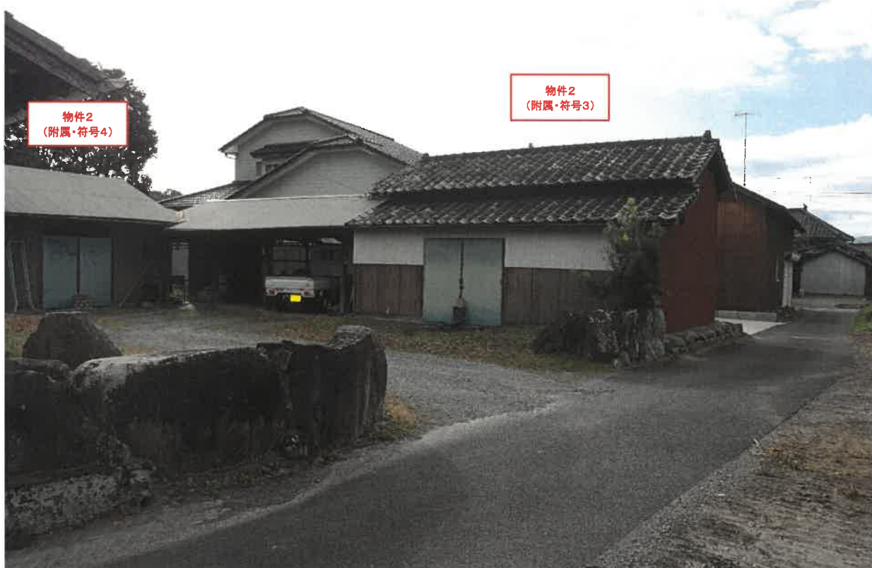
敷地南側の状況
