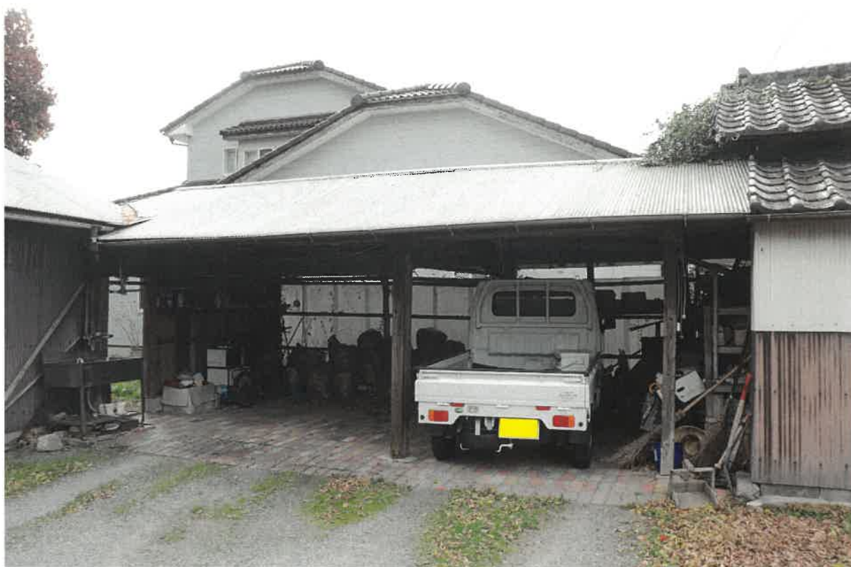
木造車庫（売却対象物件）
