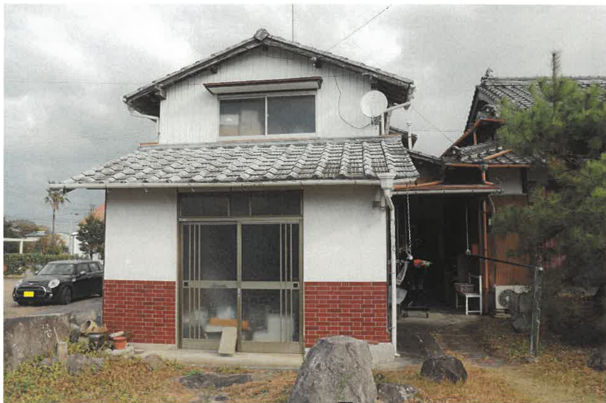
物件2（主である建物）
