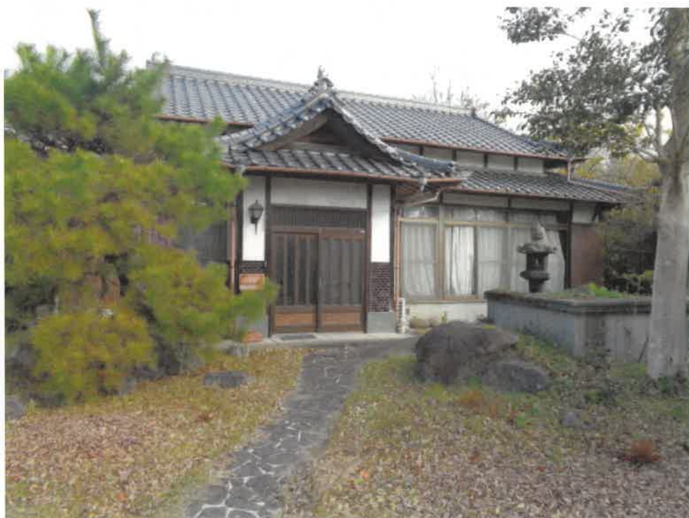
(写真3) 物件3の建物
