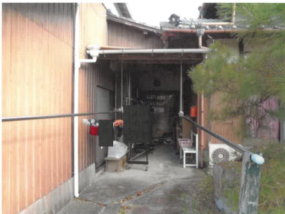
(写真4) 物件2の主たる建物と物件3の建物間に設置された渡廊下
