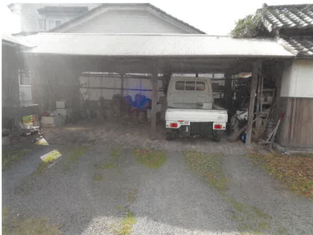
(写真 8) 売却対象物件である木造車庫
