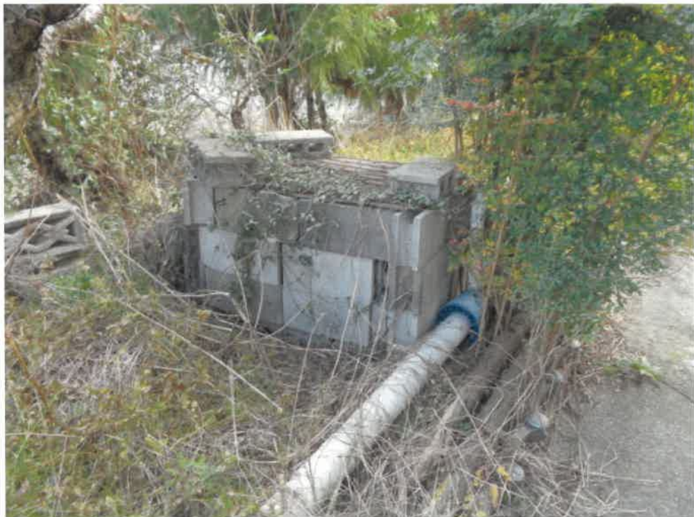
(写真7) 物件1の土地に掘削されたボーリング井戸
