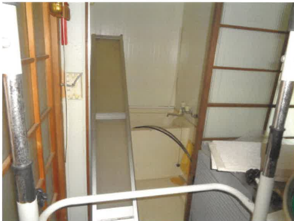
(写真6) 本件建物内部 (浴室)
