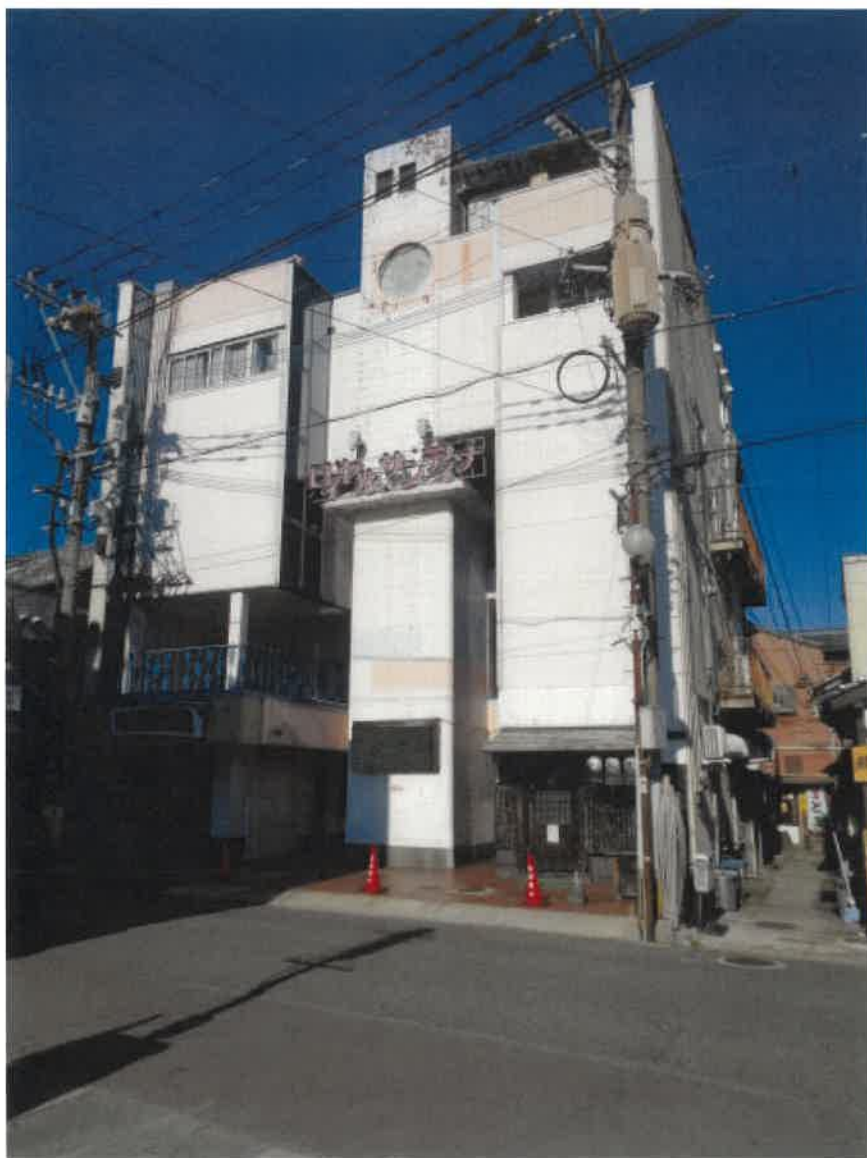
(写真1) 本件1棟の建物全景
