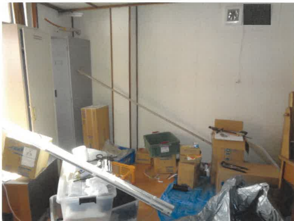
(写真4) 本件建物内部
