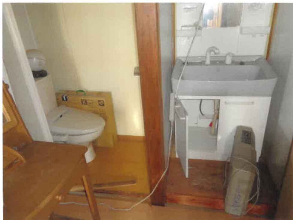
(写真5) 本件建物内部 (トイレ・洗面所)
