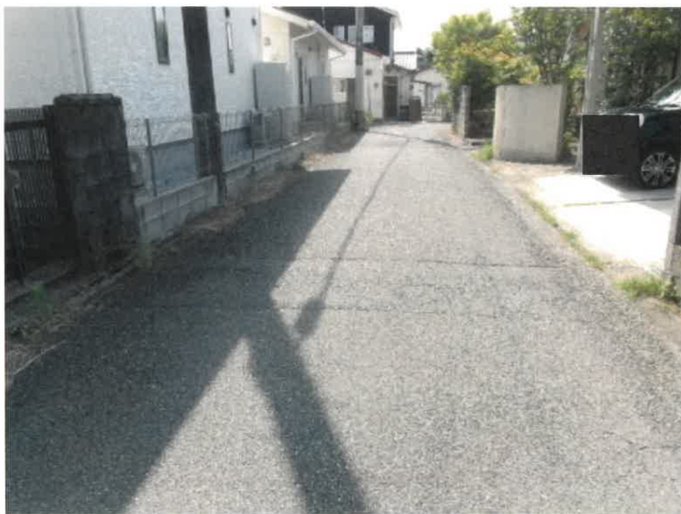
(写真6) 本件土地の接面道路
