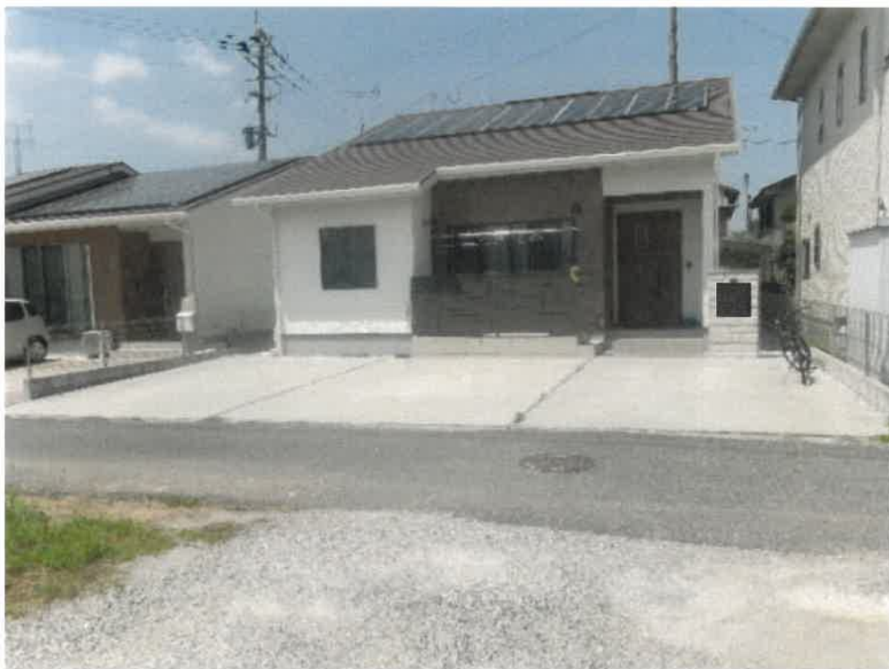
(写真1) 本件土地建物全景
