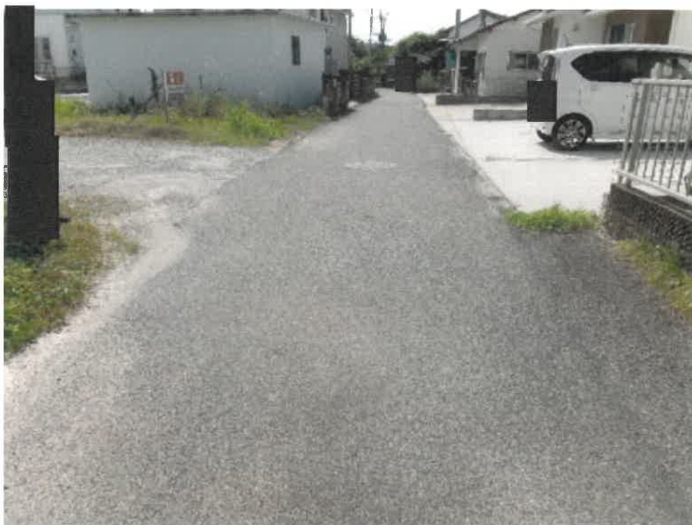
(写真5) 本件土地の接面道路
