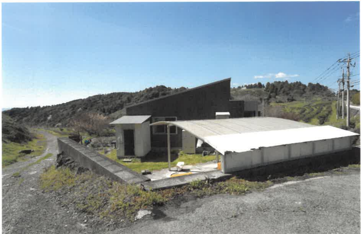
(写真②) 本件土地・建物の全景
