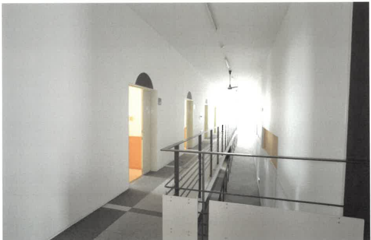
(写真㉑) 本件建物の内部
