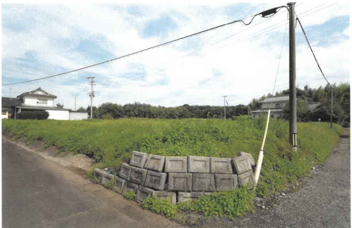
(写真②) 本件土地(物件13, 14)の全景
