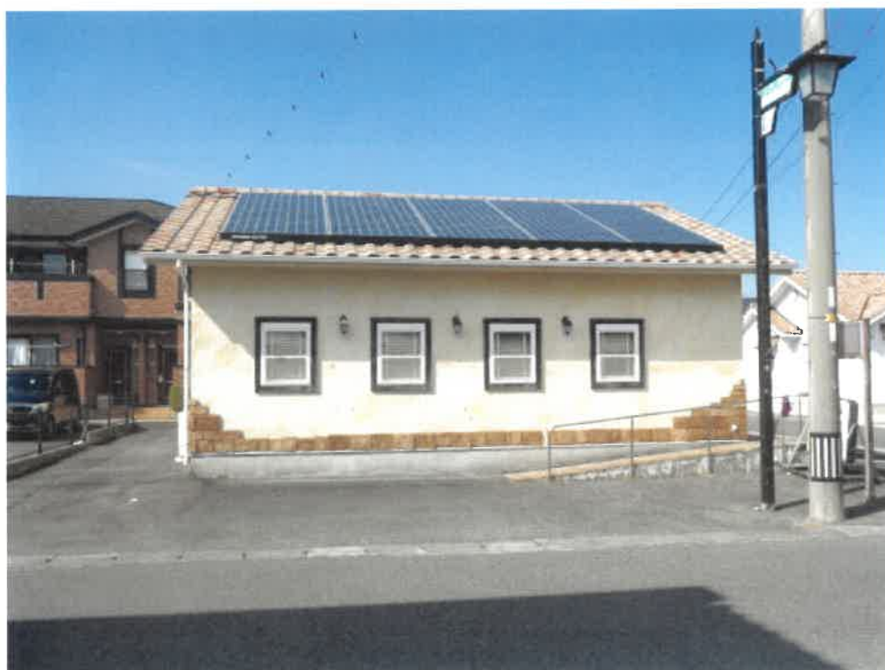
(写真2) 売却対象物件（従物）である太陽光発電システム
