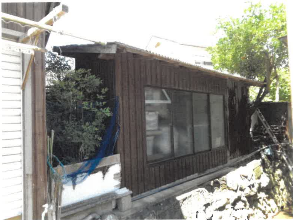
(写真3) 未登記附属建物
