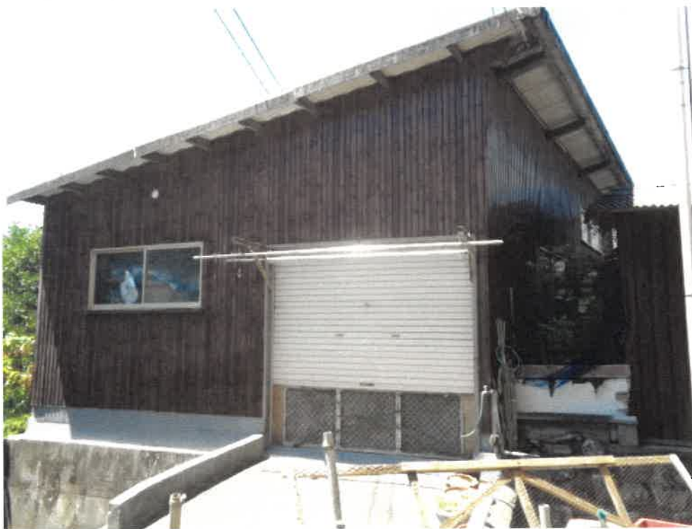
(写真2) 未登記附属建物
