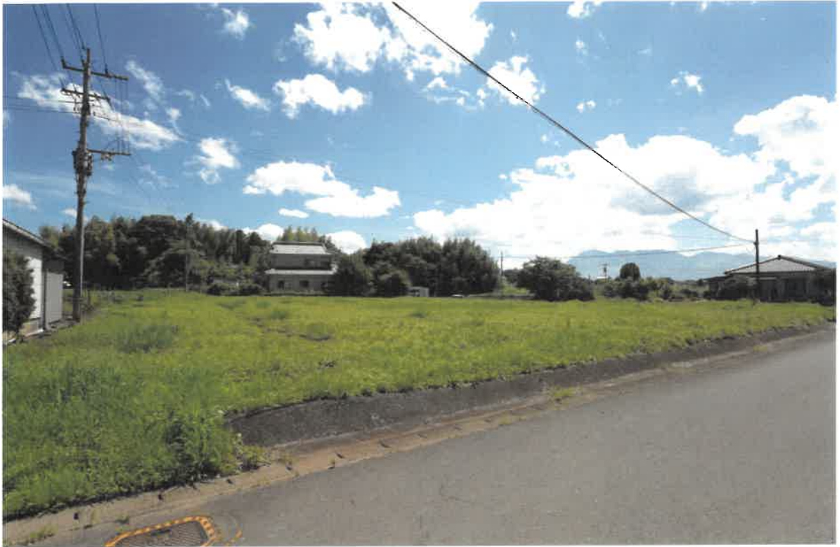
(写真①) 本件土地(物件13, 14)の全景
