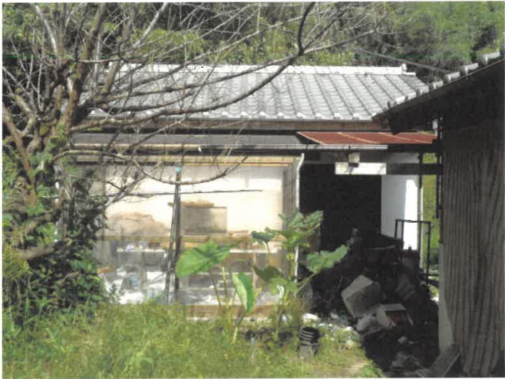
(写真 4) 未登記附属建物
