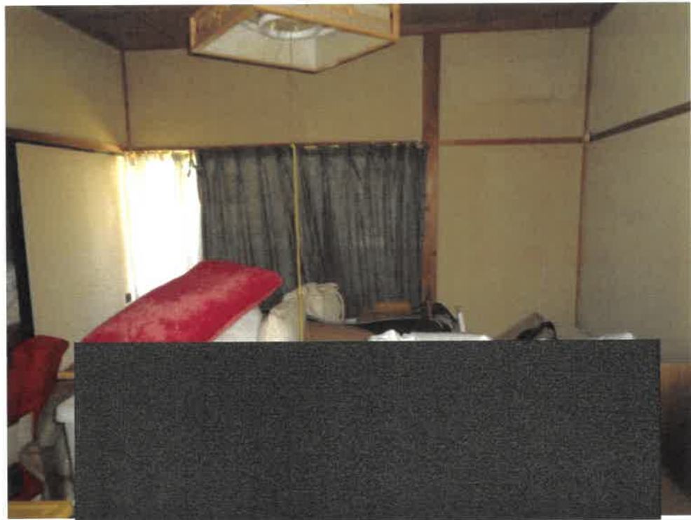
(写真1 2) 本件建物内部 (1階)
