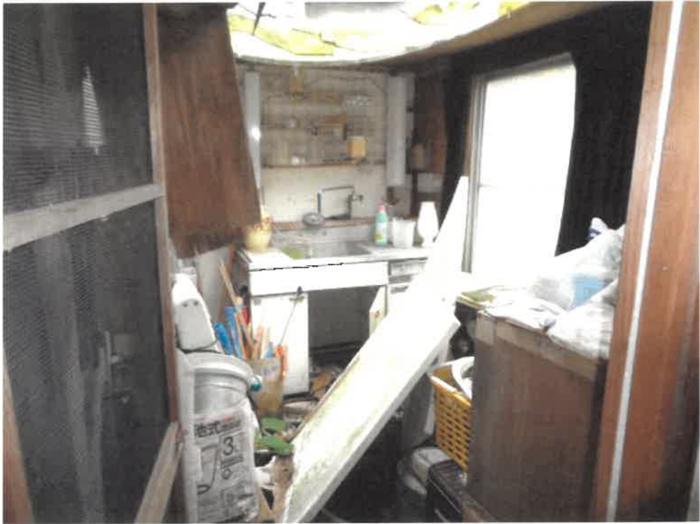
(写真1 1) 主たる建物内部 (2階)
