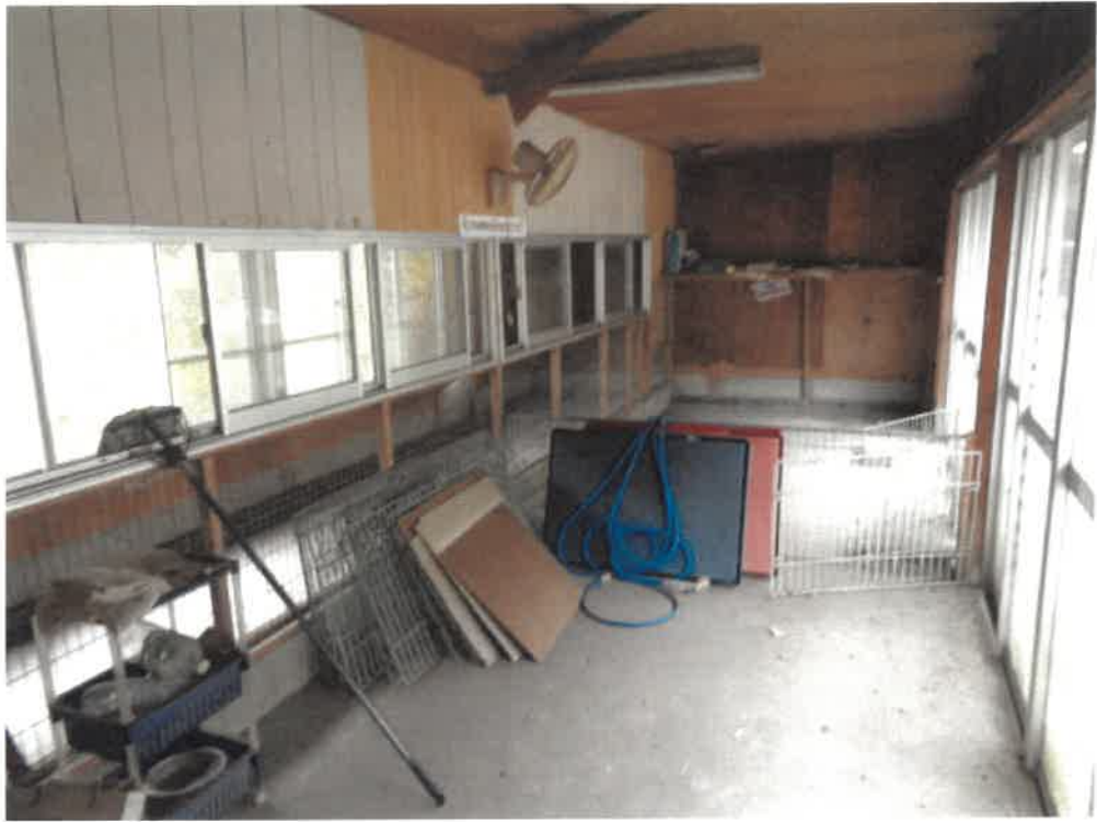
(写真21) 符号1の附属建物内部(2階)
