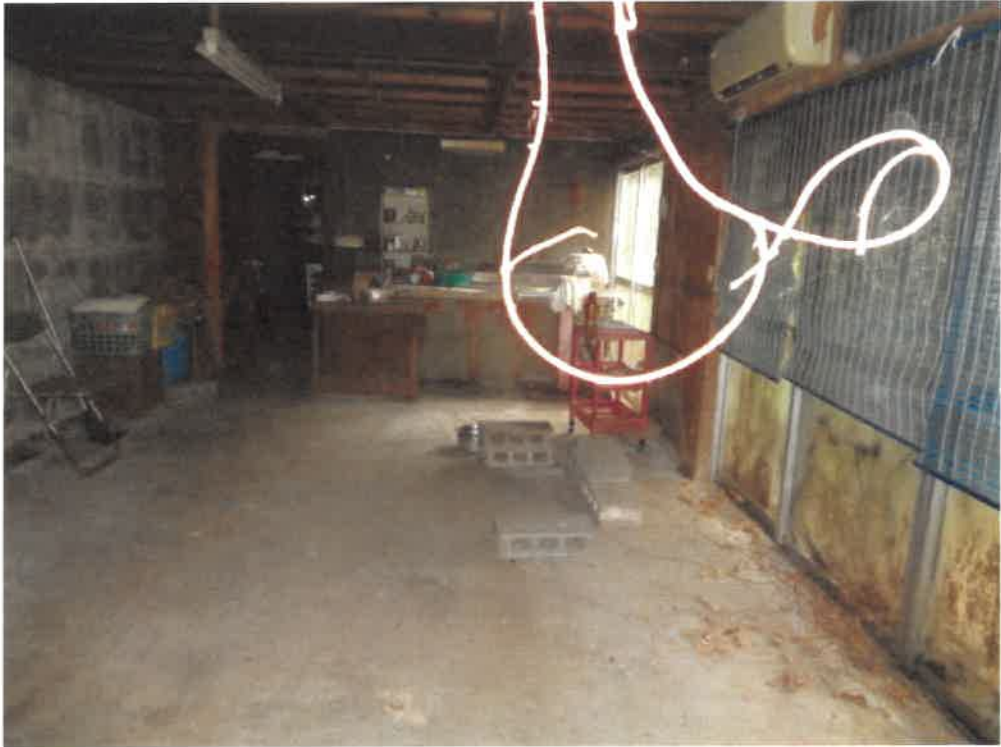
(写真13) 附属建物内部(1階)
