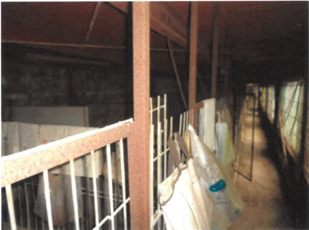
(写真16) 符号1の附属建物内部(1階)
