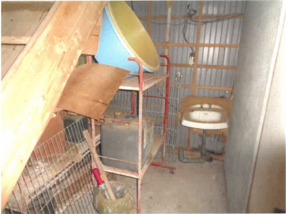
(写真15) 附属建物内部(1階)
