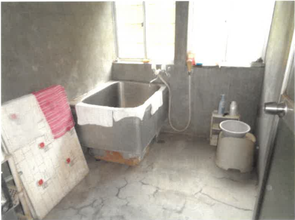
(写真14) 附属建物内部(1階)
