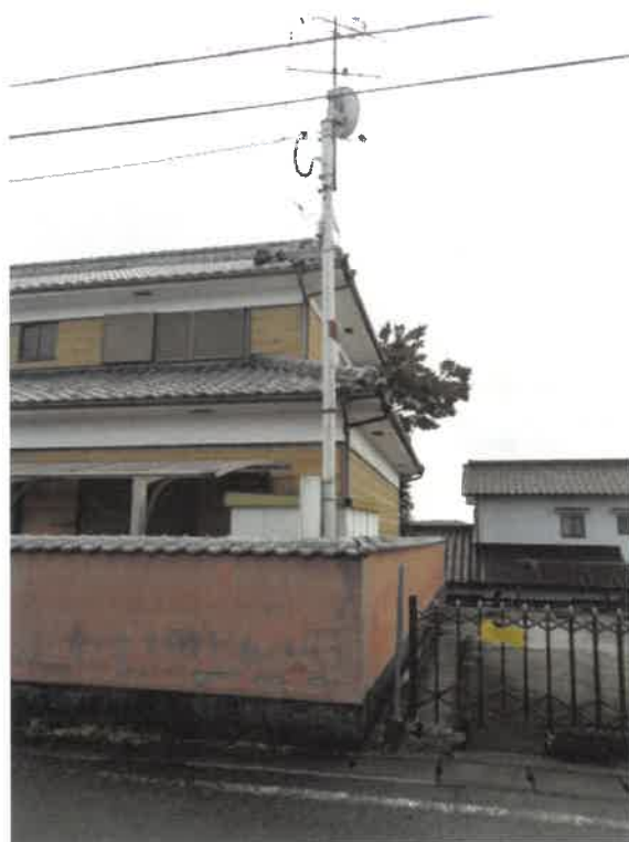
(写真4) 売却対象物件であるアンテナ柱
