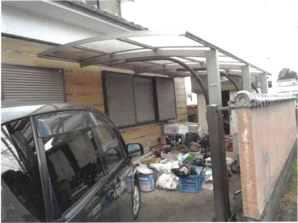
(写真5) 売却対象物件であるカーポート
