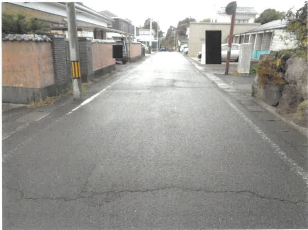
(写真2) 本件土地の接面道路（市道）
