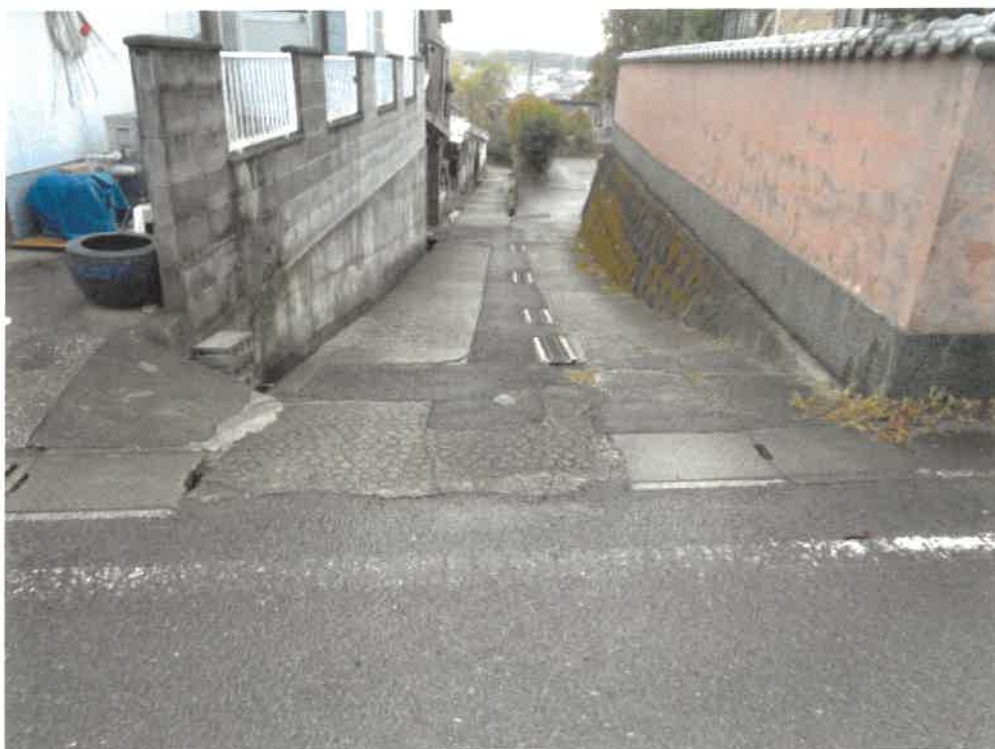
(写真3) 本件土地の接面道路(里道)
