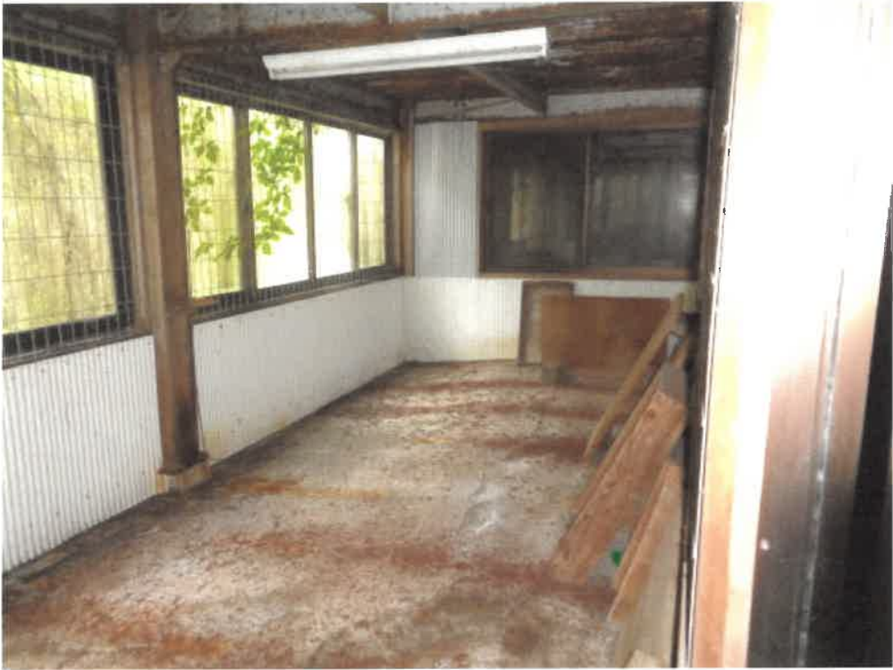
(写真5) 主たる建物内部 (1階: 未登記増築部分)
