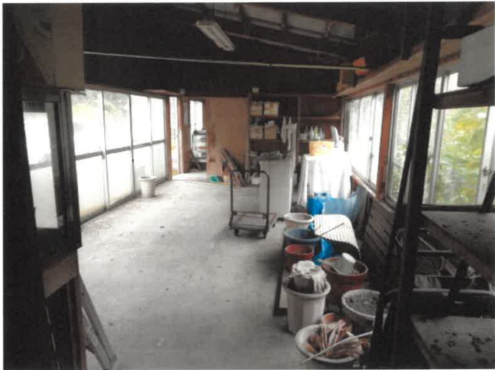
(写真18) 符号1の附属建物内部(2階)
