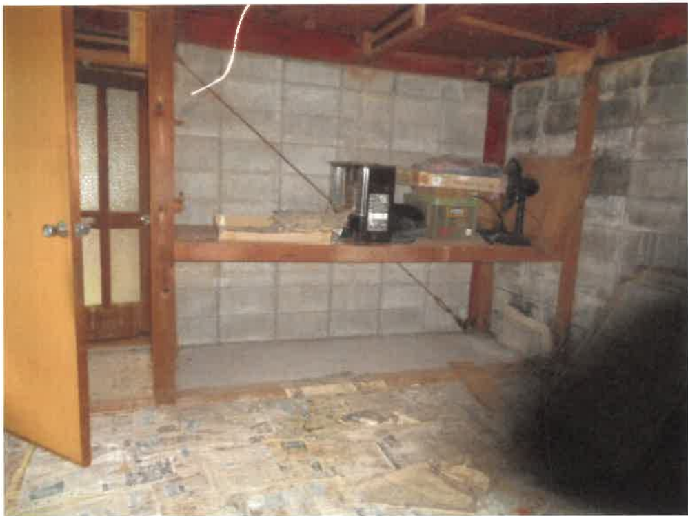
(写真1 2) 附属建物内部 (1階)
