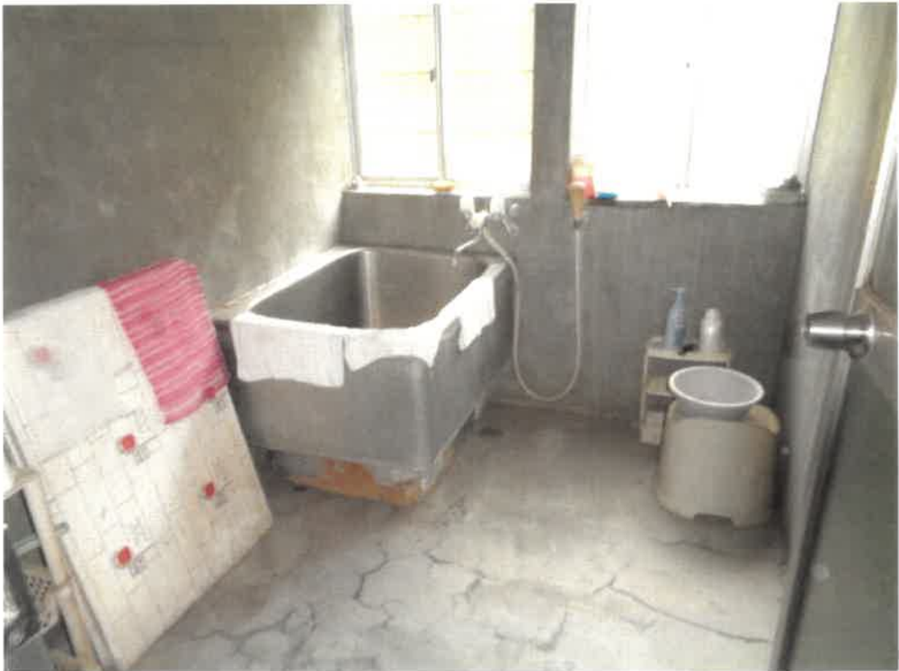
(写真14) 附属建物内部 (1階)
