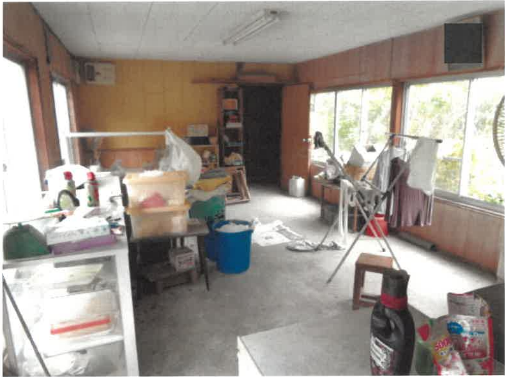
(写真17) 符号1の附属建物内部(2階)
