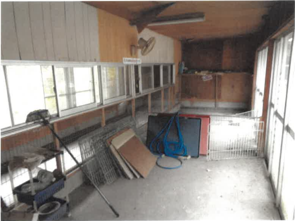
(写真21) 符号1の附属建物内部(2階)
