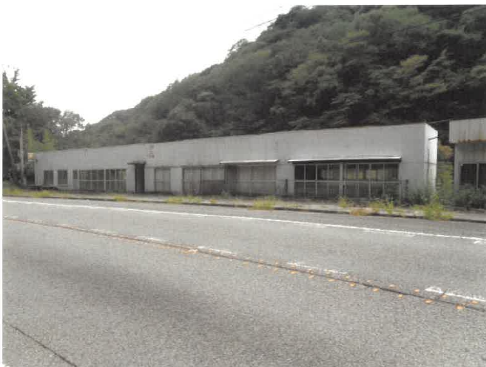
(写真3) 符号1の附属建物
