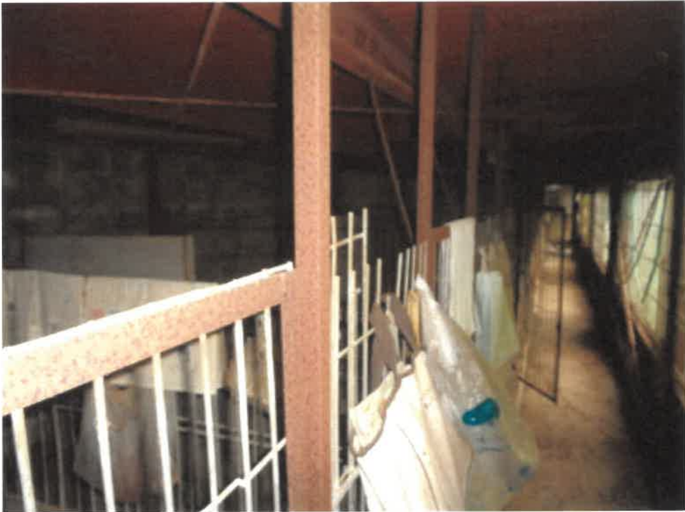
(写真16) 符号1の附属建物内部(1階)
