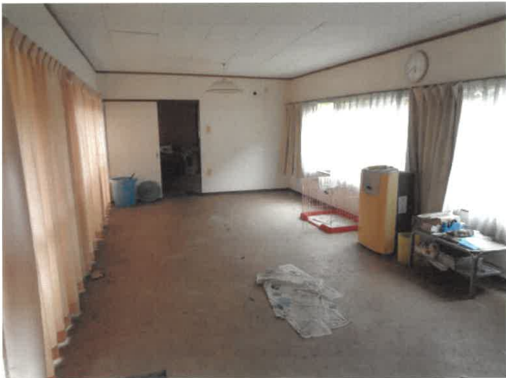
(写真20) 符号1の附属建物内部(2階)
