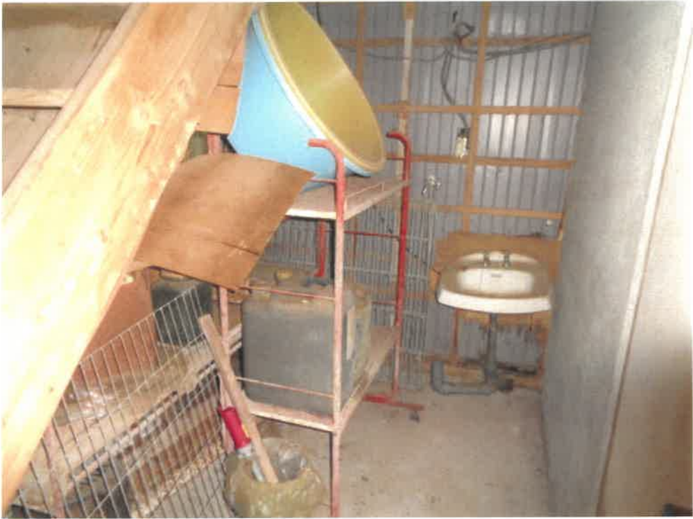
(写真15) 附属建物内部(1階)
