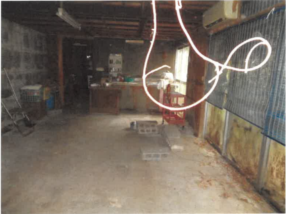
(写真13) 附属建物内部 (1階)
