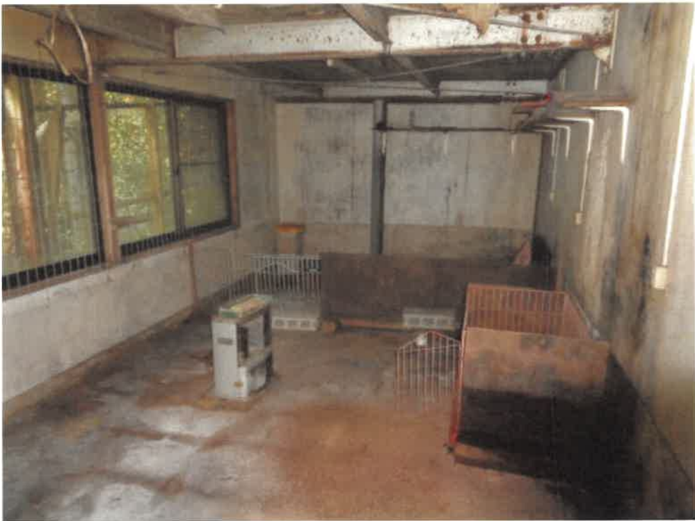
(写真6) 主たる建物内部 (1階: 未登記増築部分)
