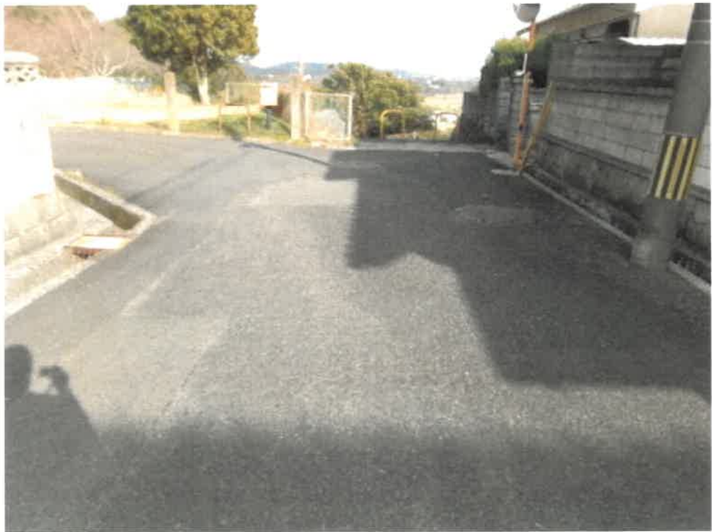
(写真4) 本件土地の接面道路
