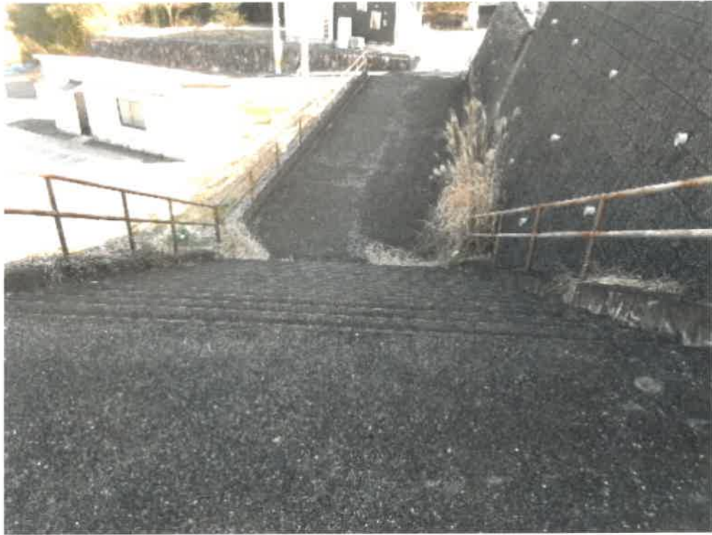
(写真7) 本件土地の接面道路
