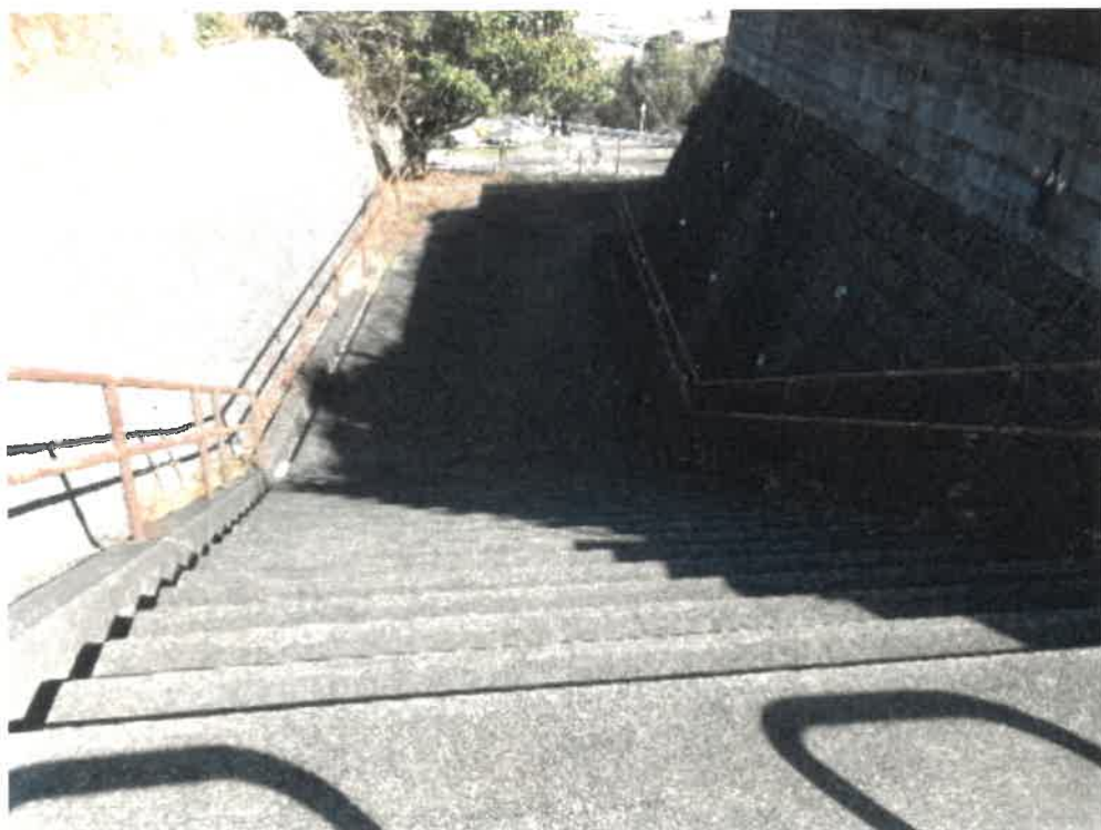
(写真6) 本件土地の接面道路
