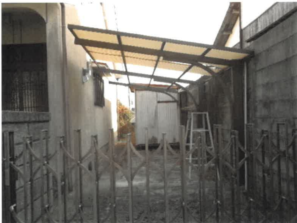
(写真2) 売却対象物件（本件土地に定着）であるカーポート
