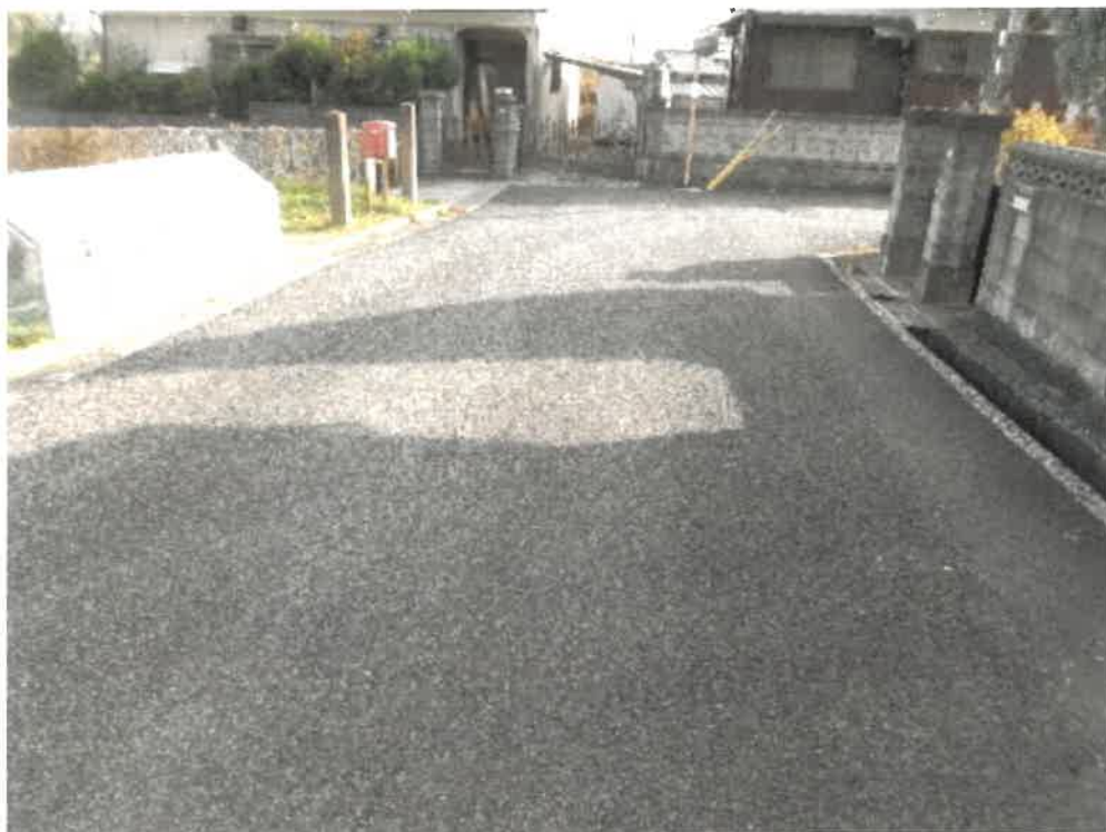
(写真5) 本件土地の接面道路
