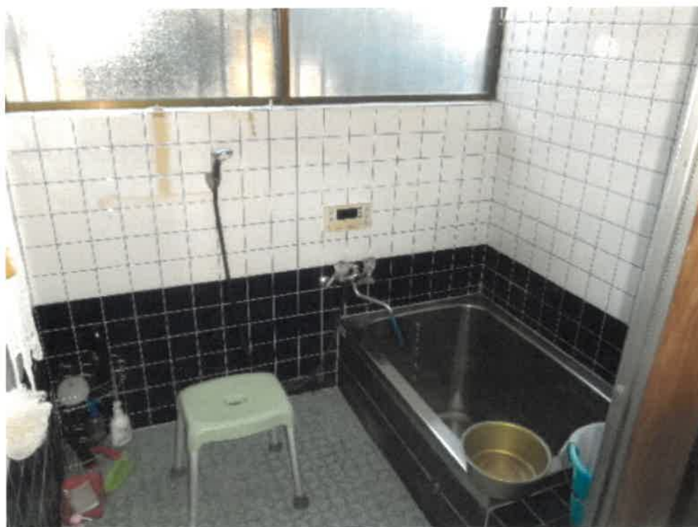
(写真 1 4) 本件建物内部
