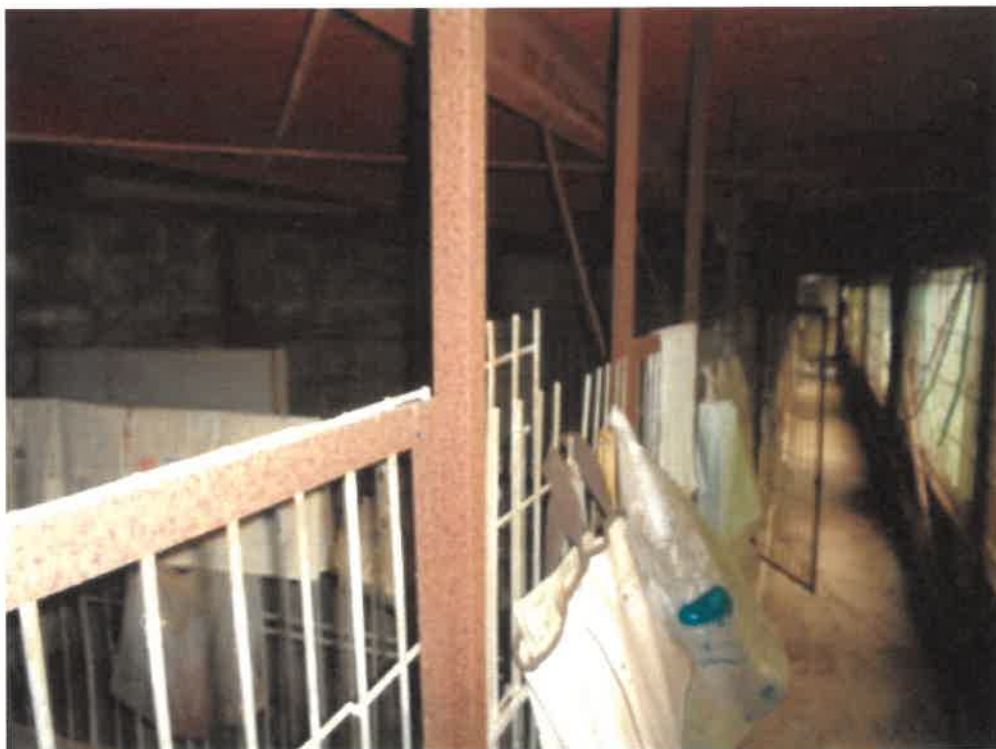
(写真 1 6) 符号 1 の附属建物内部 (1 階)
