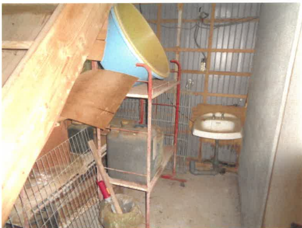
(写真 1 5) 附属建物内部 (1 階)
