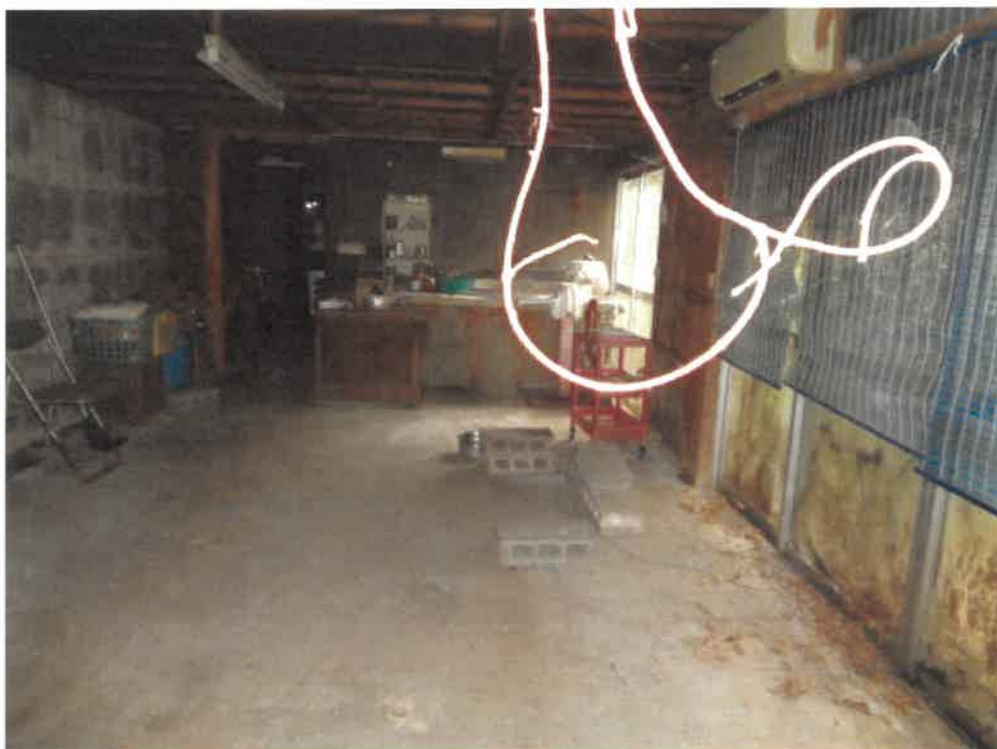
(写真 1 3) 附属建物内部 (1 階)
