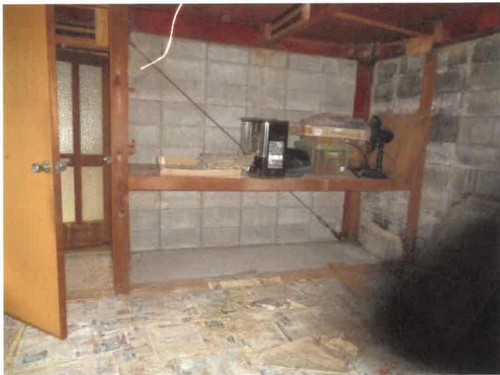
(写真 1 2) 附属建物内部 (1 階)
