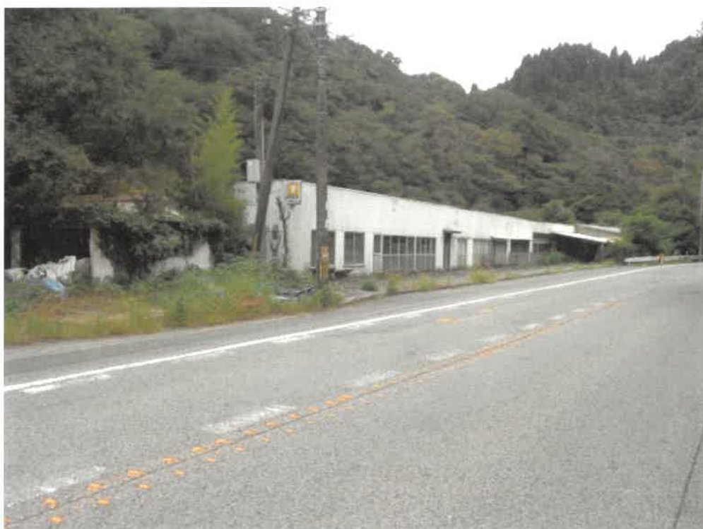
(写真1) 本件土地建物全景
