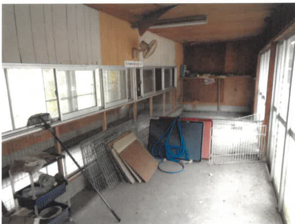
(写真 2 1) 符号 1 の附属建物内部 (2 階)
