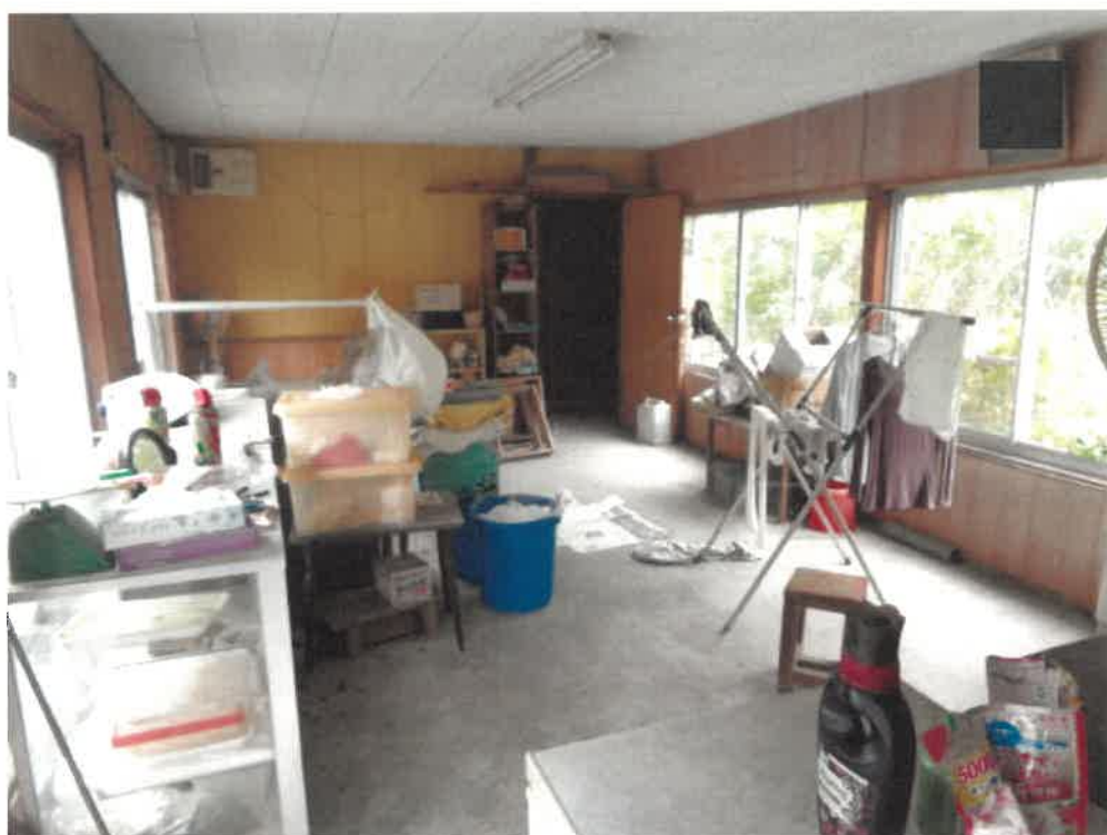
(写真 1 7) 符号 1 の附属建物内部 (2 階)
