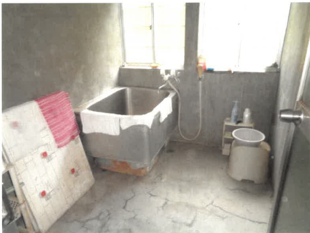
(写真 1 4) 附属建物内部 (1 階)
