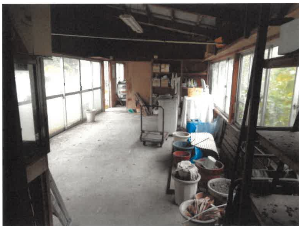
(写真 1 8) 符号 1 の附属建物内部 (2 階)
