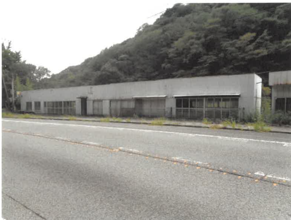
(写真3) 符号1の附属建物
