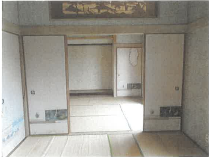
写真⑪建物内部
