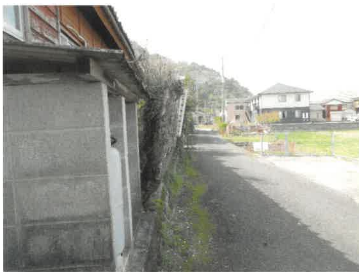
写真③柵が傾き市道に越境している状況
