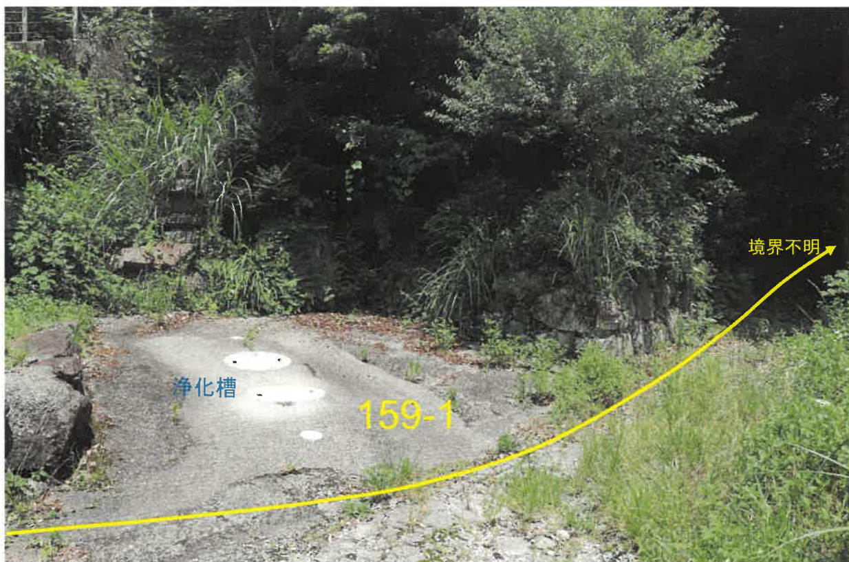
建屋北側の駐車場（浄化槽設置）
