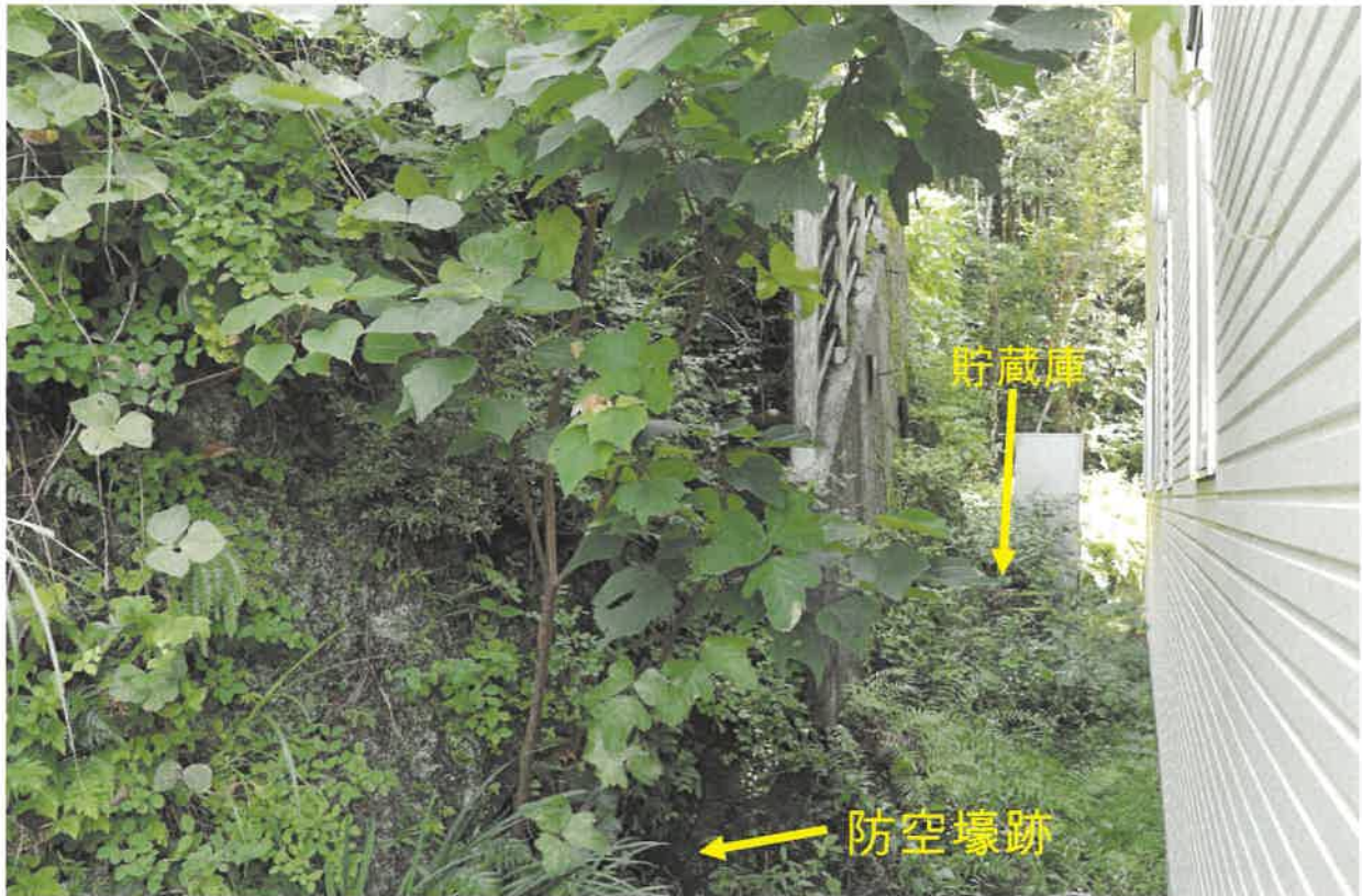
建物西側背後の状況（急傾斜地）
