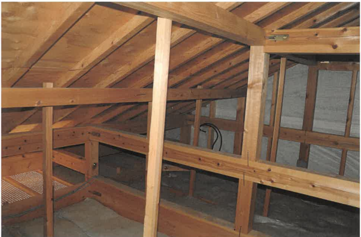
屋根裏の状況
