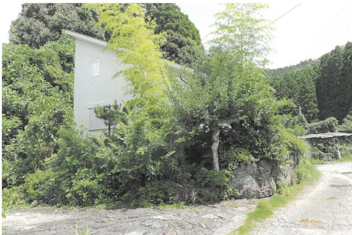
対象物件；南方より
