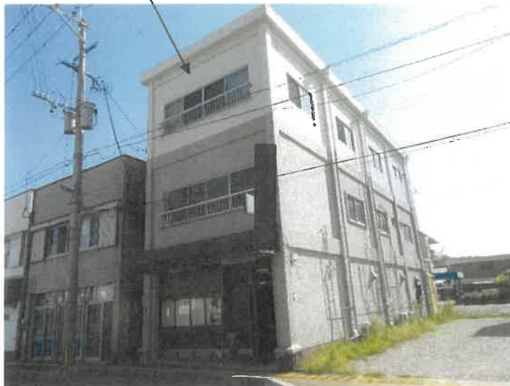
写真②目的外土地 下屋庇
