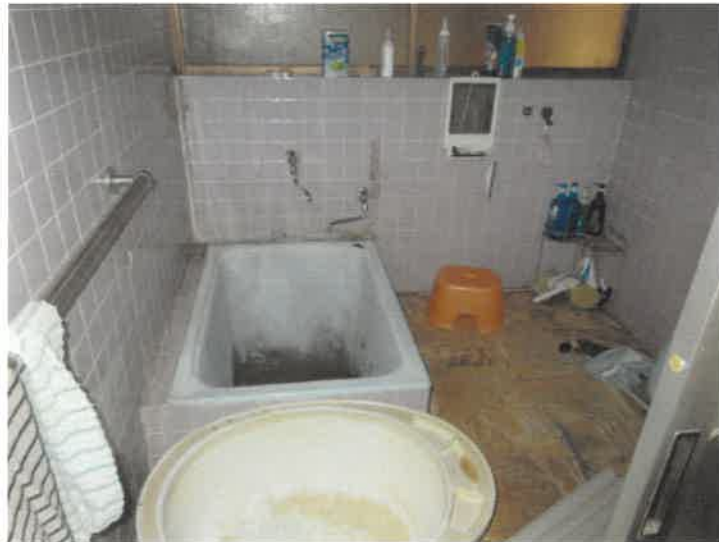
写真⑧建物内部
