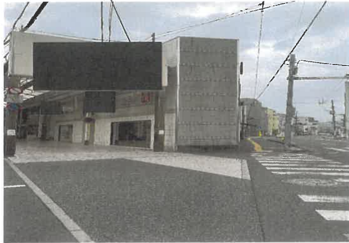
写真①本件建物
