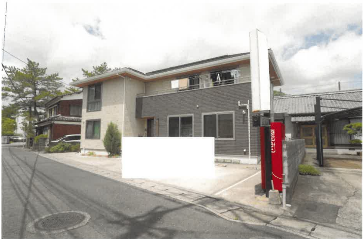
(写真①) 本件土地・建物の全景
