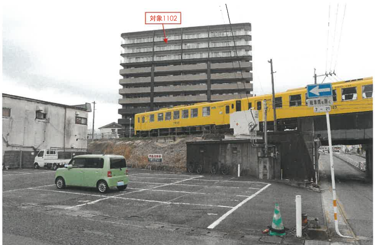
マンション全景（南方から）
