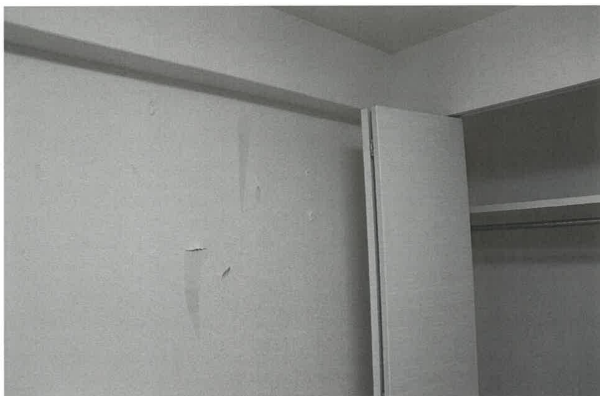
クロスの損傷箇所（洋室②）
