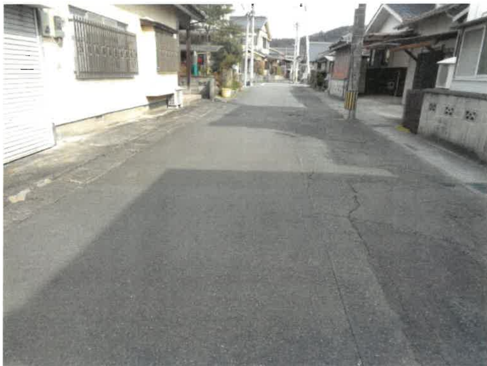
(写真2) 本件土地の接面道路(市道)
