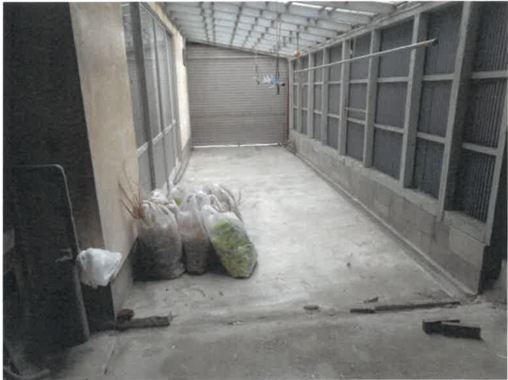
(写真1 2) 本件建物内部 (1 階)
