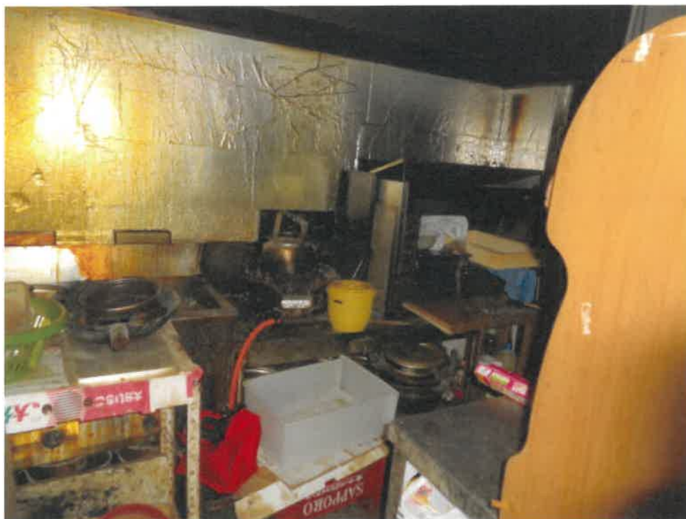
(写真5) 物件2の建物内部(1階)
