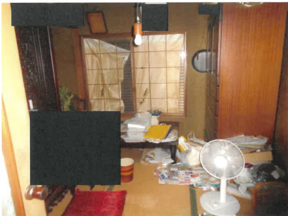
(写真 7) 本件建物内部 (1 階)
