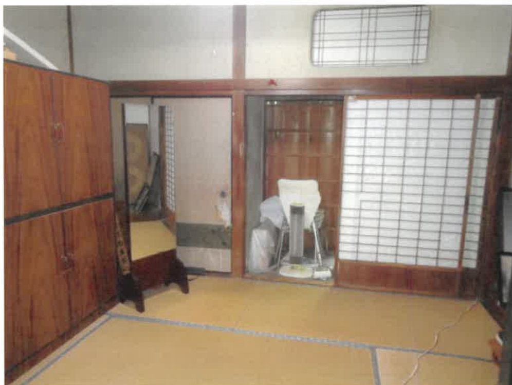
(写真 1 4) 本件主たる建物内部 (1 階)
