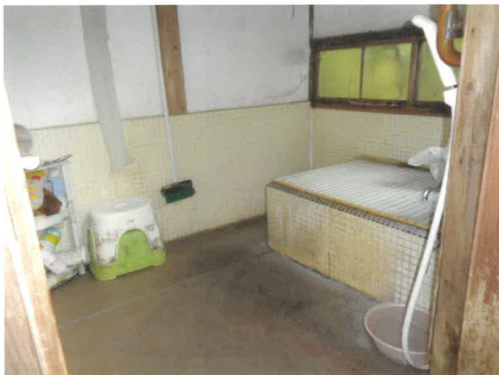
(写真 2 0) 符号 2 の附属建物内部 (浴室部分)
