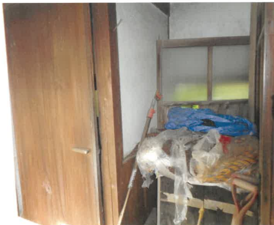
(写真 2 1) 符号 2 の附属建物内部 (便所部分)
