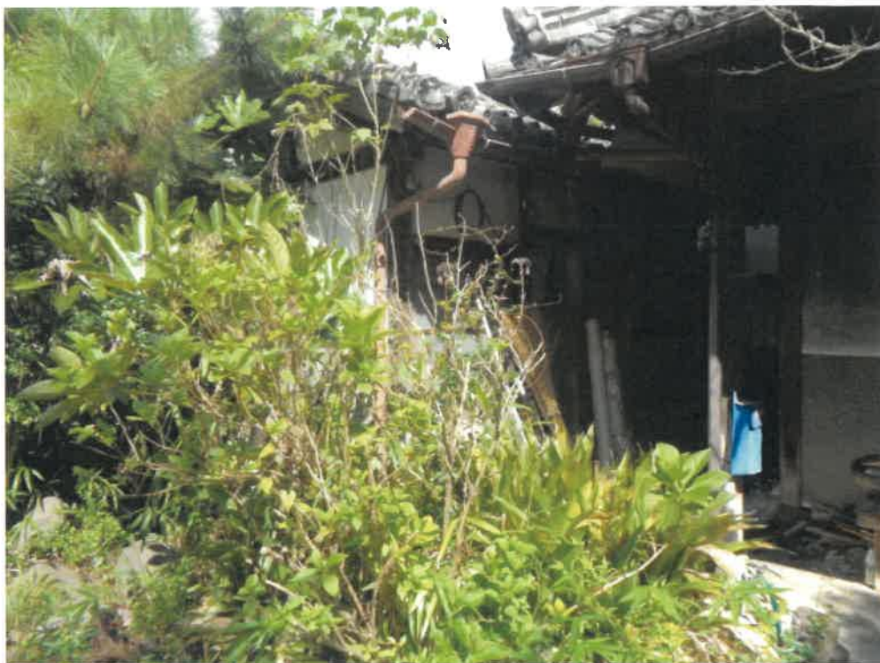
(写真6) 符号2の附属建物
