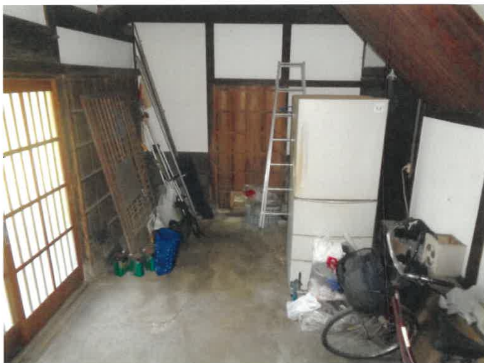
(写真 1 6) 本件主たる建物内部 (1 階)
