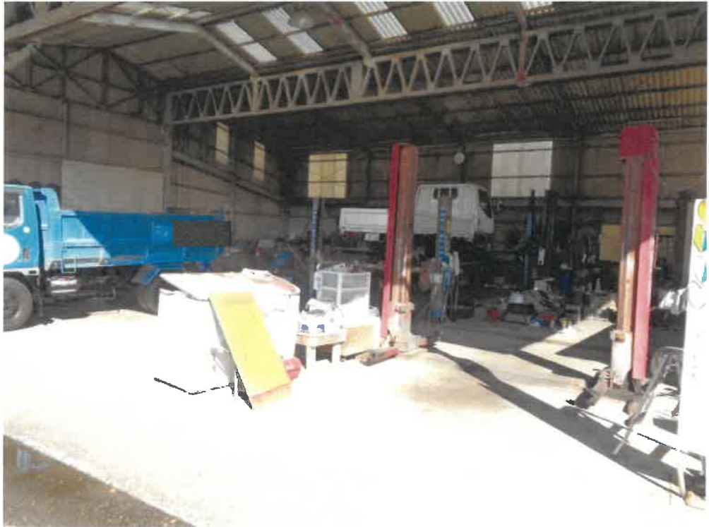
(写真 8) 物件 6 の主たる建物内部
