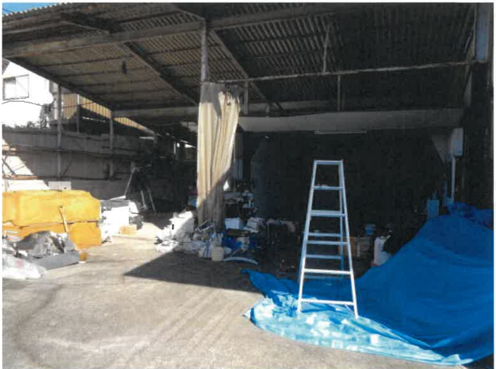
(写真 9) 物件 6 の主たる建物内部
