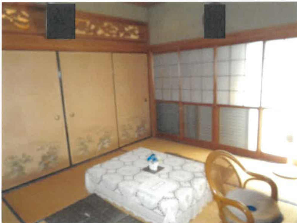
(写真5) 物件3の建物内部(1階)
