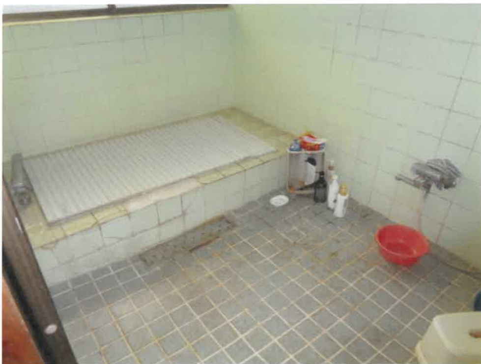
(写真 1 1) 物件 3 の建物内部 (1 階)
