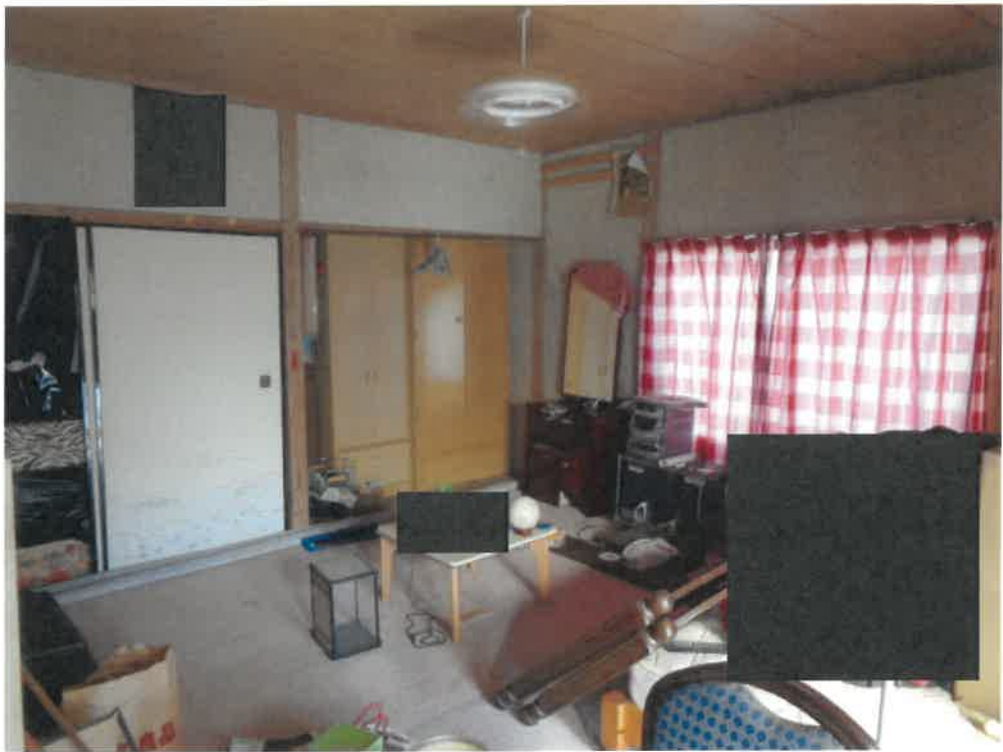
(写真 1 7) 物件 3 の建物内部 (2 階)
