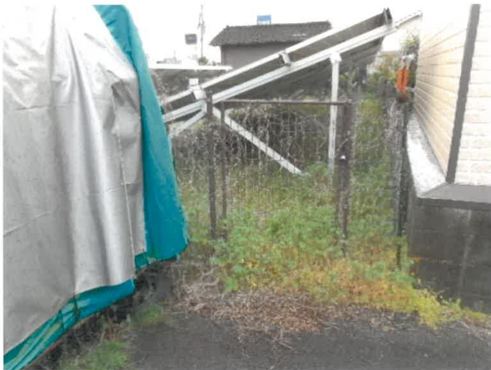
(写真6) 金網フェンスに設けられた扉
