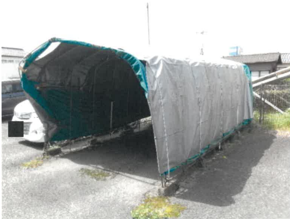
(写真4) 売却対象外物件であるパイプ車庫
