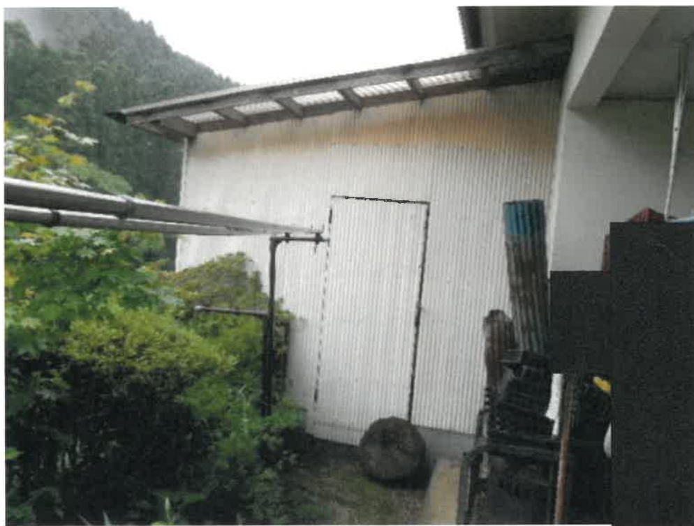
(写真8) 増築部分
