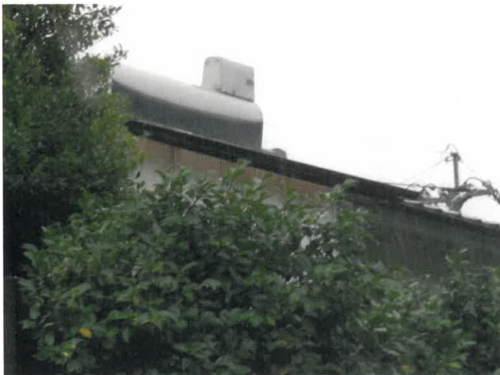
(写真 10) 従物である太陽熱温水器
