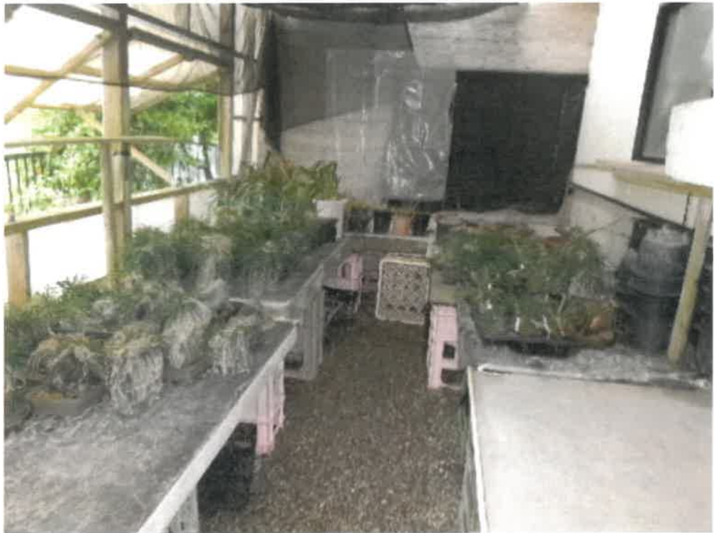
(写真 2 7) 符号 1 の附属建物の増築部分内部 (温室)
