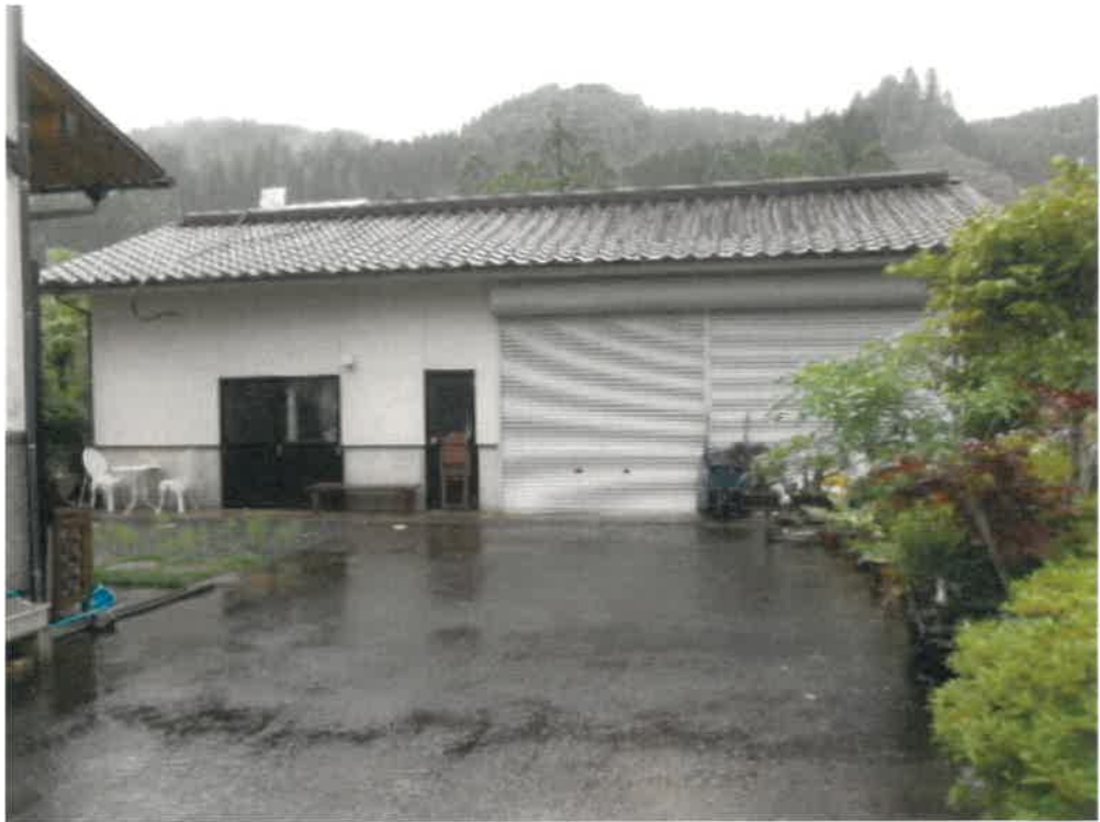
(写真3) 符号1の附属建物
