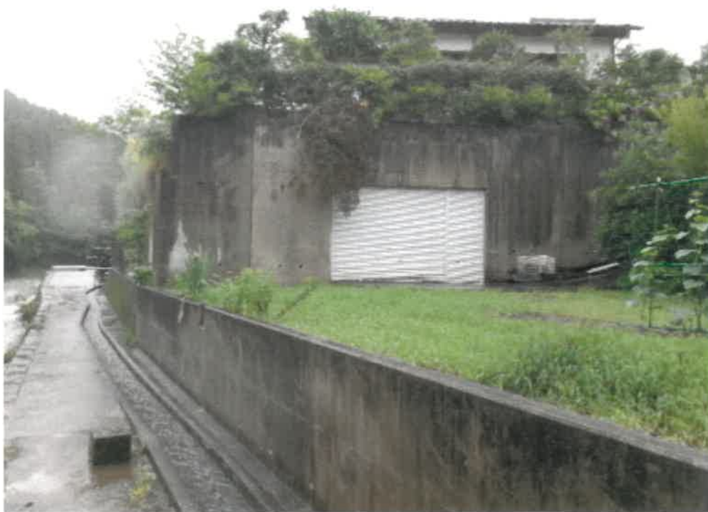
(写真7) 倉庫 (シャッター部分)
