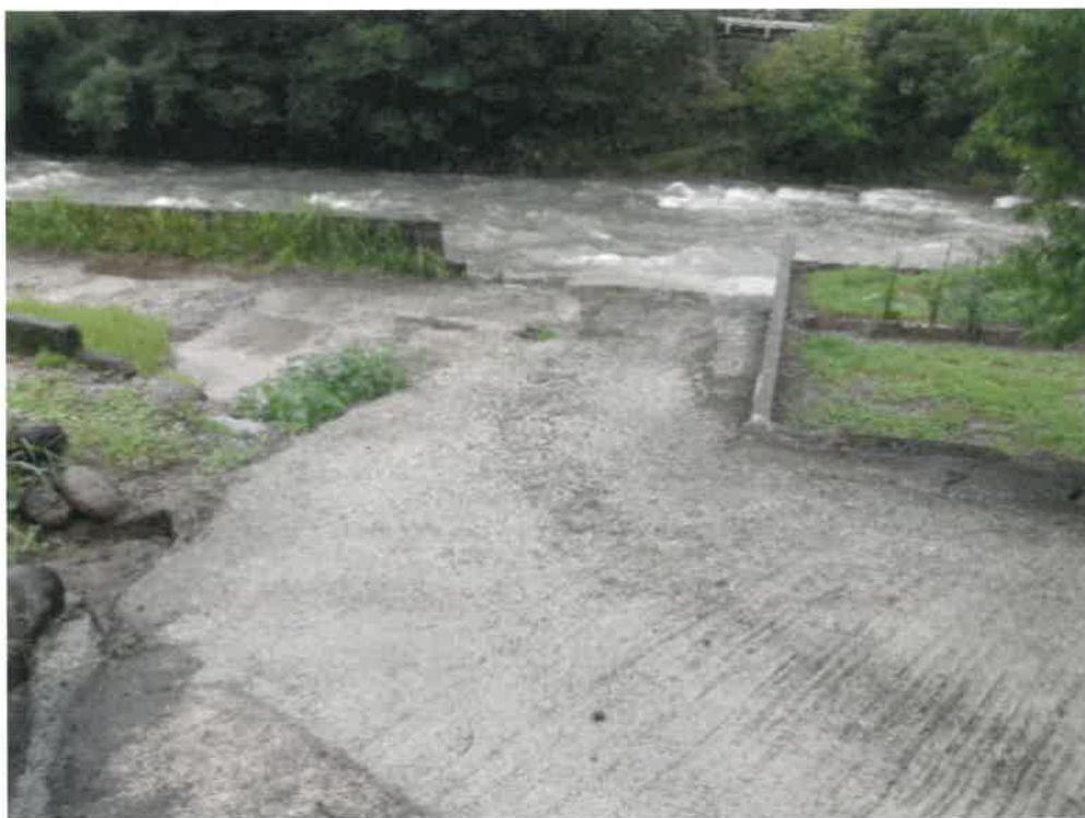
(写真6) 本件土地の接面道路
