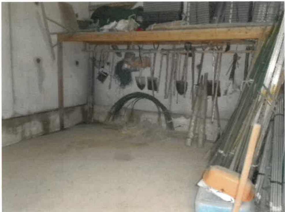
(写真 2 8) 未登記附属建物 (堀倉庫) 内部
