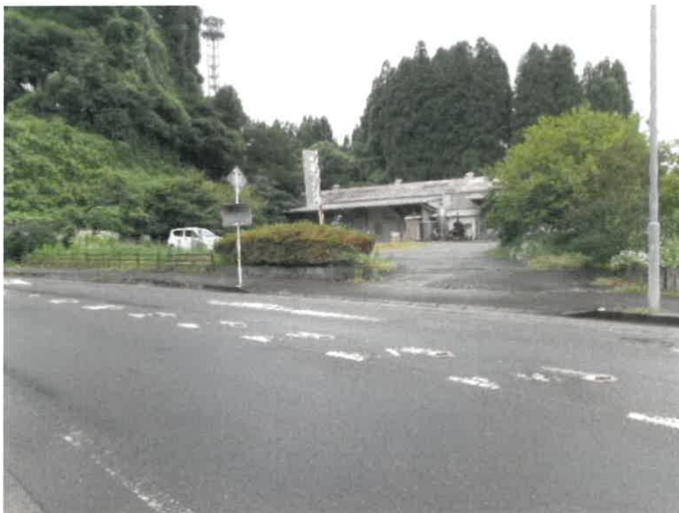
(写真1) 本件土地建物全景
