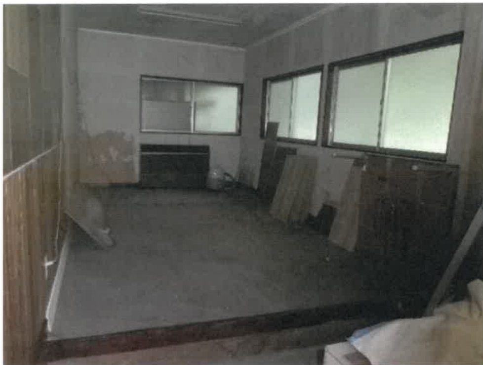
(写真 1 5) 本件建物内部
