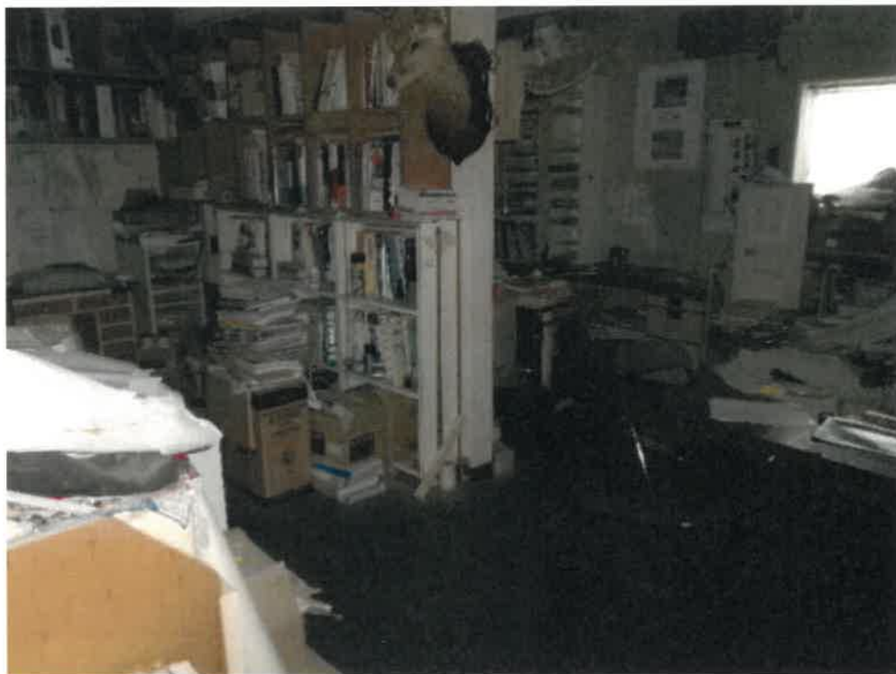
(写真 10) 本件建物内部
