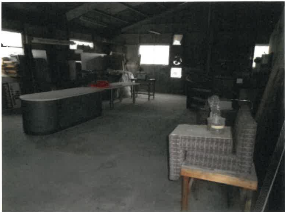
(写真1 2) 物件9の建物内部(3階)
