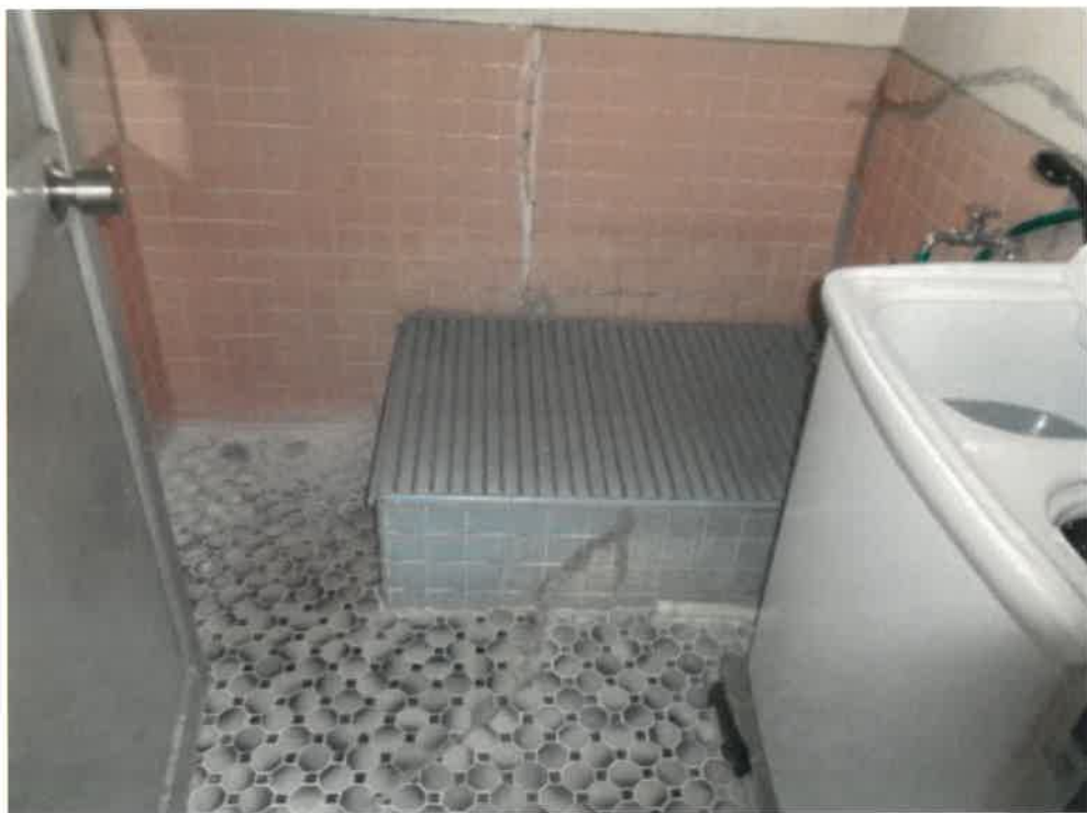
(写真 1 8) 物件 1 0 の建物内部 (1 階)
