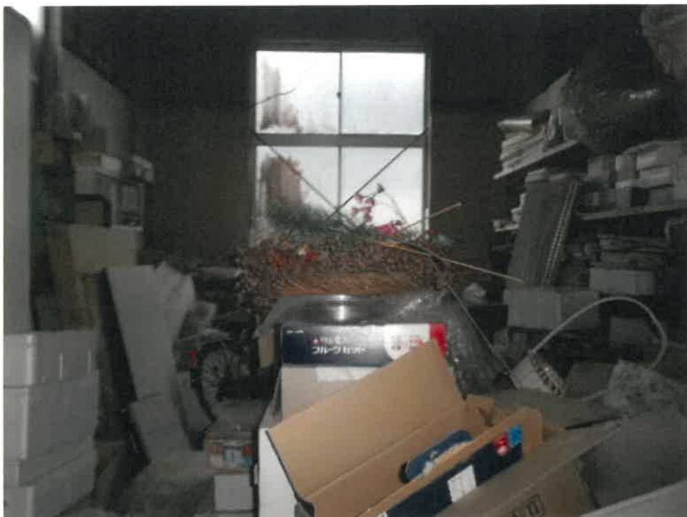
(写真 9) 物件 9 の建物内部 (1 階)
