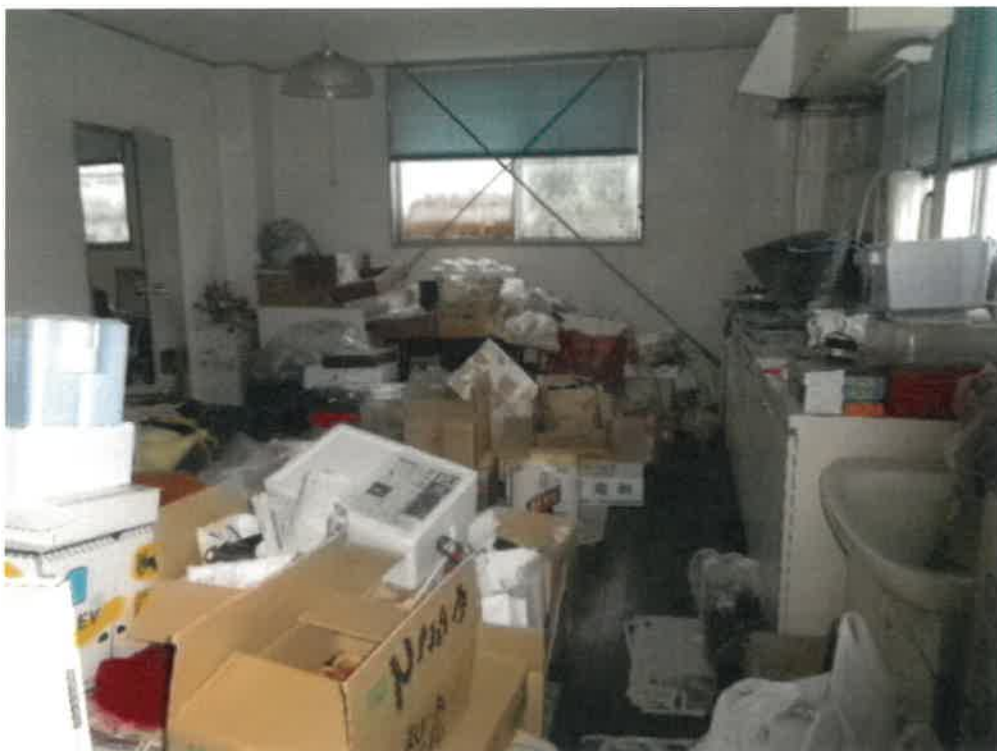
(写真7) 物件9の建物内部(1階)
