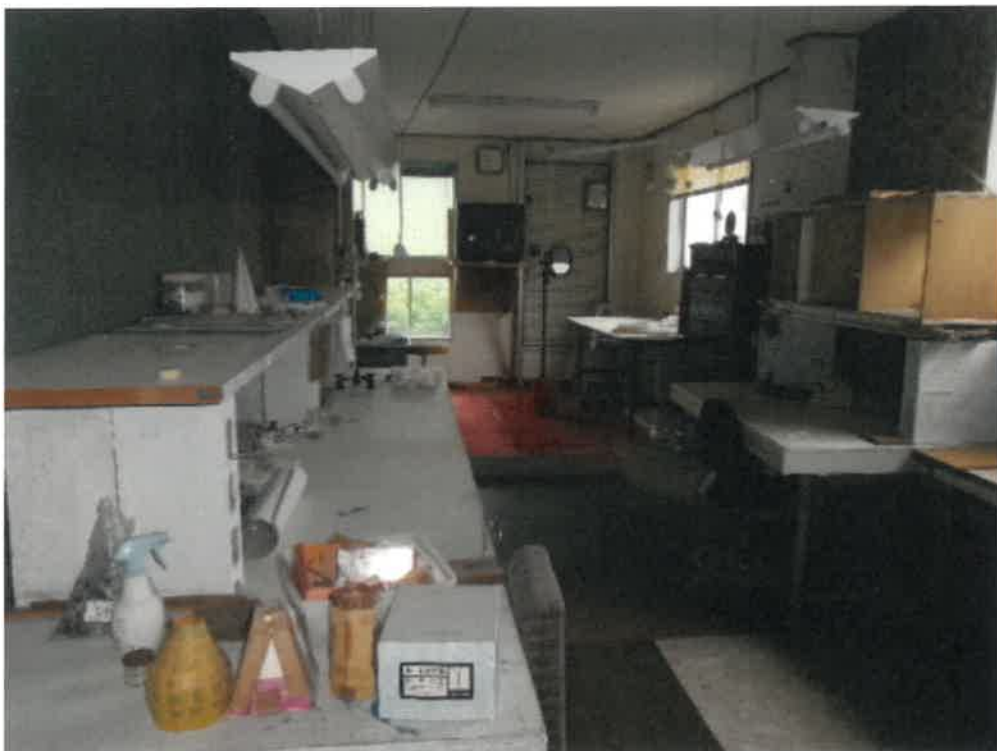
(写真 1 3) 物件 9 の建物内部 (3 階)
