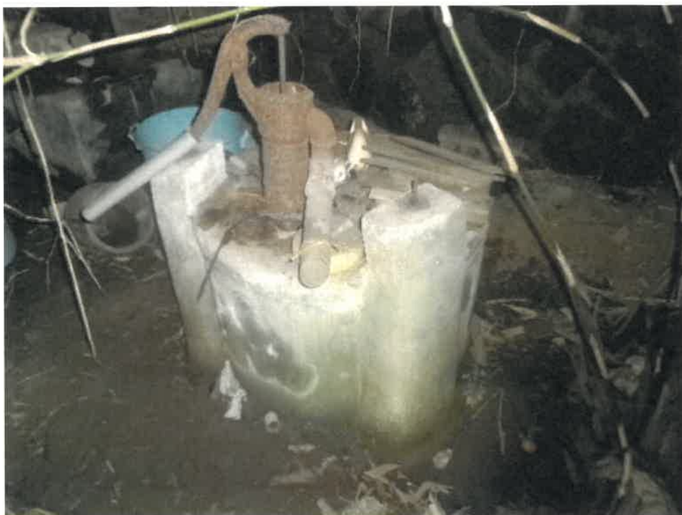
(写真 1 7) 物件 3 の主たる建物の未登記附属建物内の井戸
