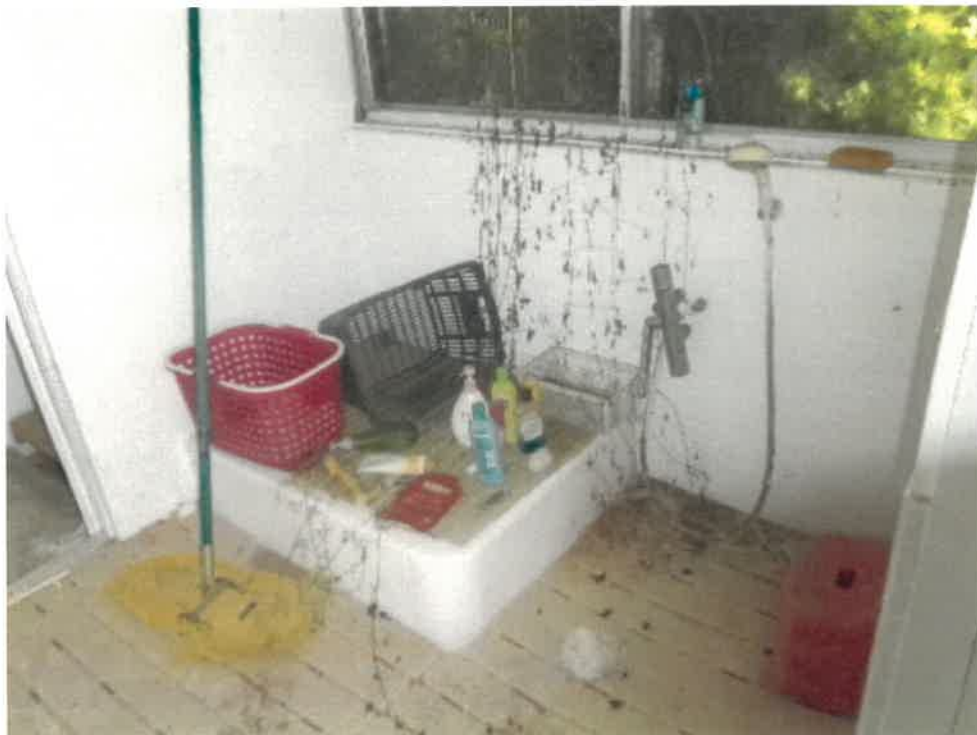
(写真 1 3) 物件 3 の主たる建物内部
