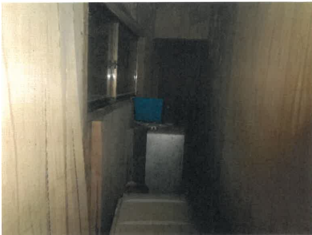
(写真 1 4) 物件 3 の主たる建物内部
