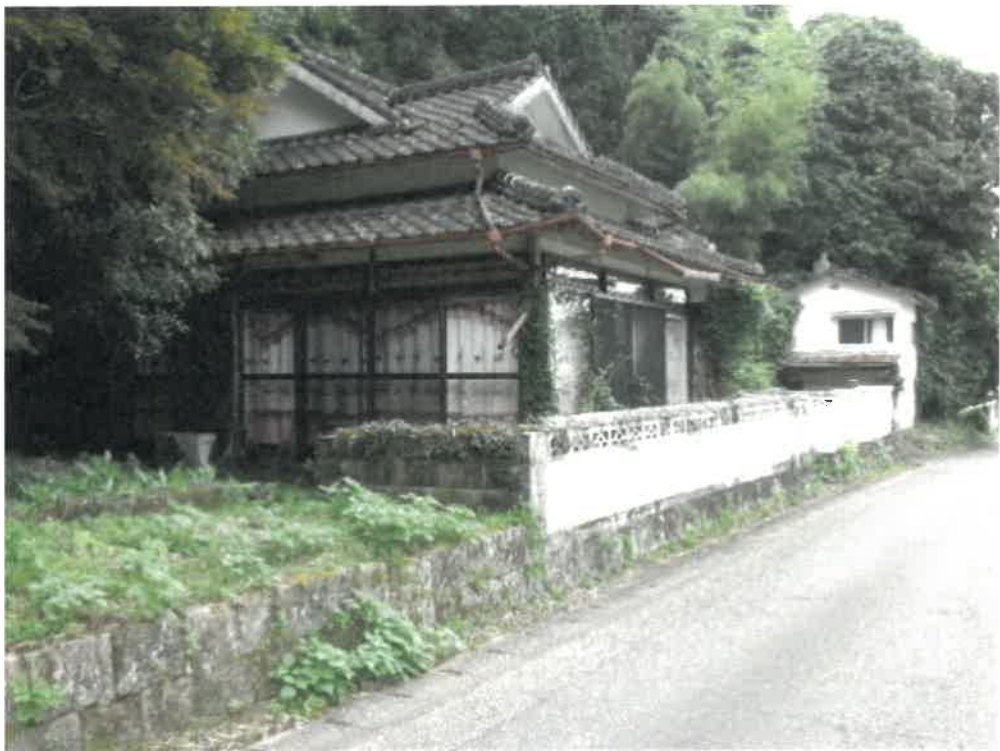
(写真1) 物件1及び3の土地建物全景
