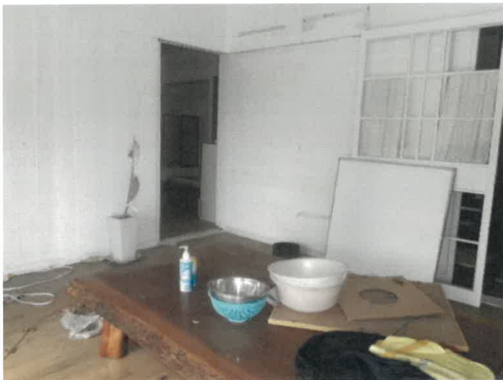
(写真 8) 物件 3 の主たる建物内部
