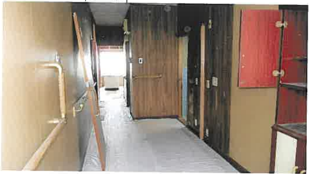
(写真 4 ) 以下、物件 4 (居宅)内部
