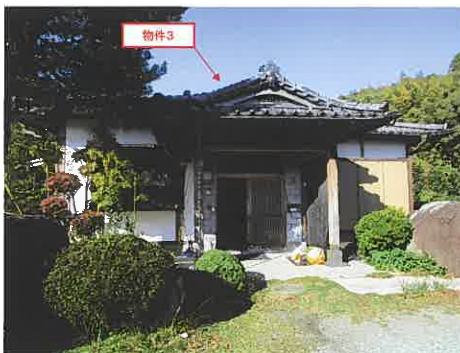
物件3 主たる建物
