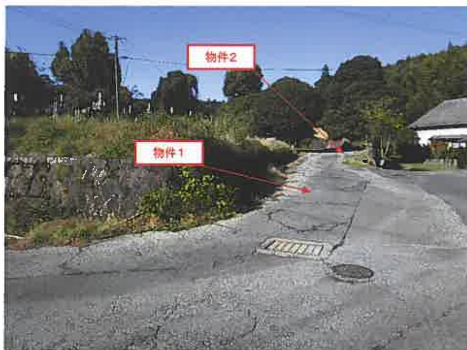
物件南方より撮影(物件番号1、2)
