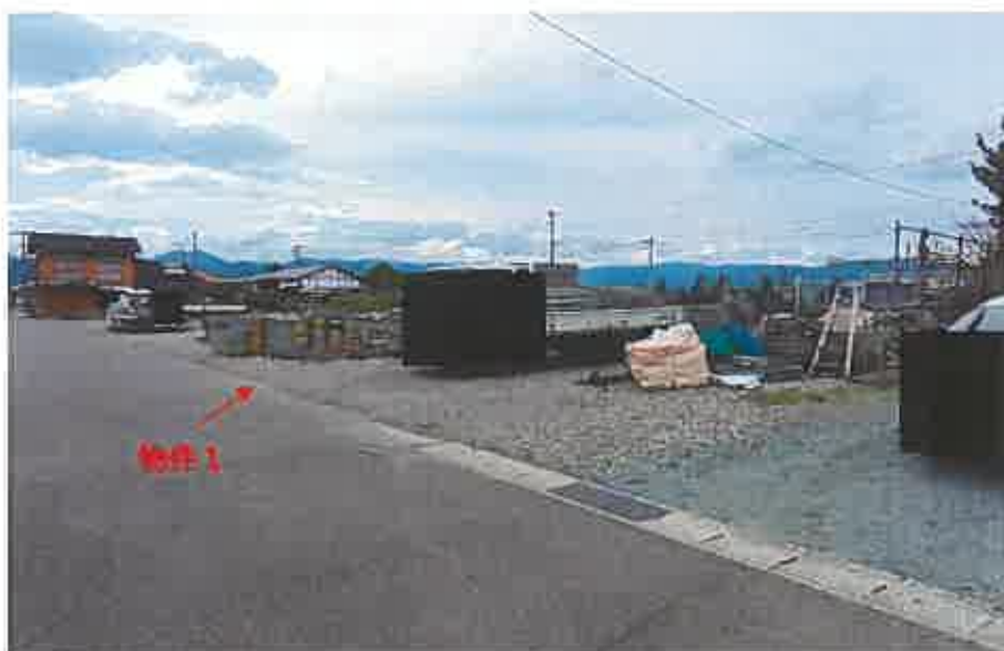
物件1 近景（北西方より）
