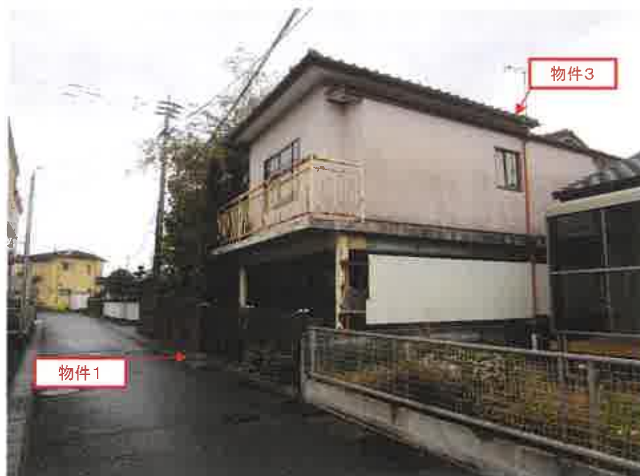
物件東方より撮影(物件1、3)
