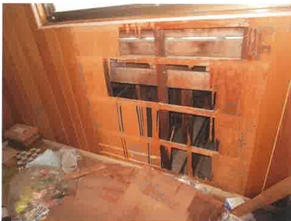
物件3 建物内部
