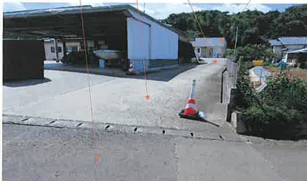
(写真2) カーポート基礎 下屋 物件1 物件4 蓄電池 カーポート基礎
