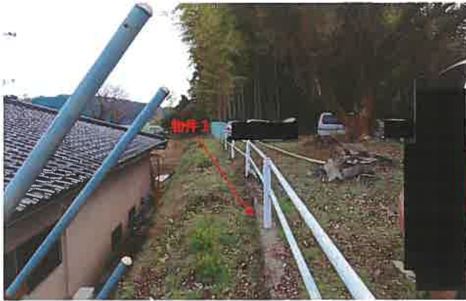
物件 1 (東側隣地)
