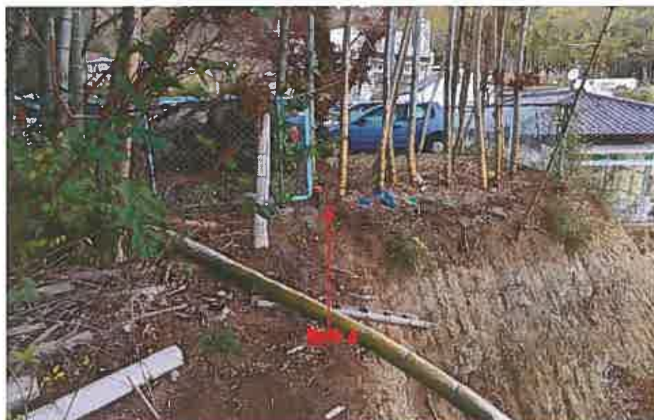
物件 4 (南東側隣地)
