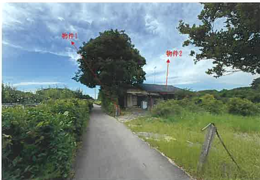
南西方より対象不動産を望む
