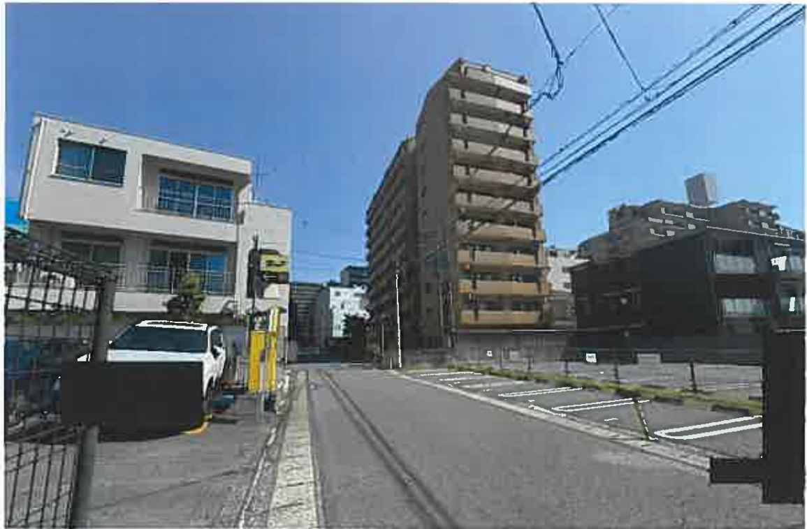
南西方より対象不動産を望む
