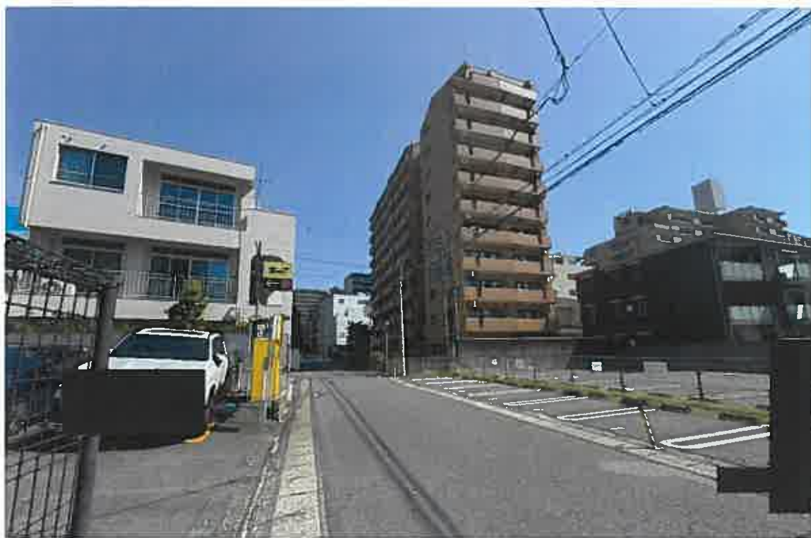
南西方より対象不動産を望む
