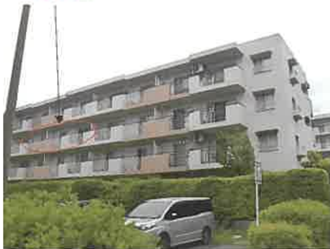
南東側よりマンション全景
