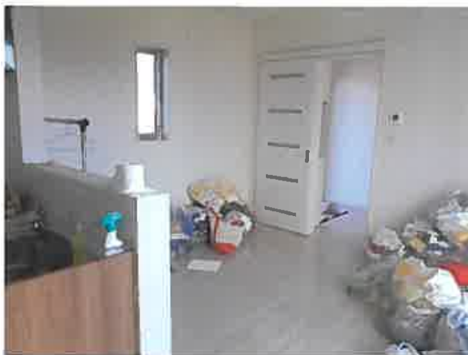
物件 2 ・ 1 階内部
