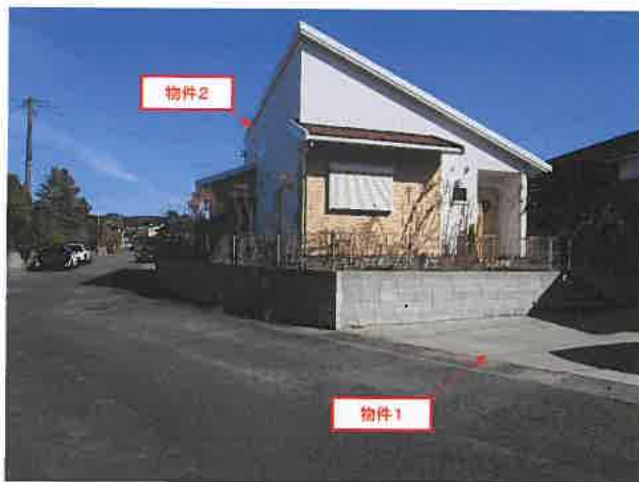
物件西方より撮影(物件番号1、2)
