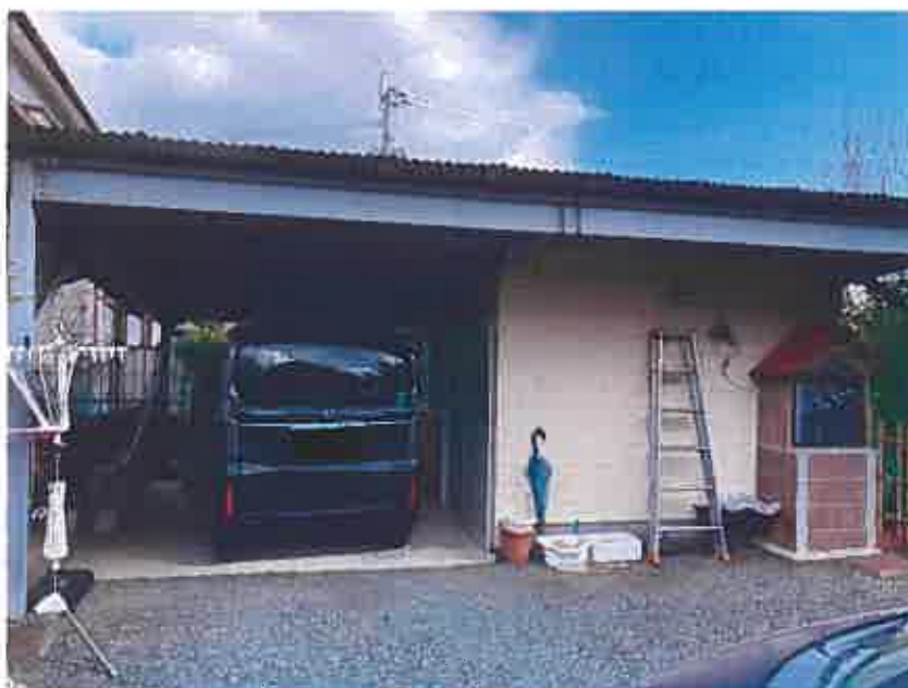
写真⑧：附属建物(物置)
