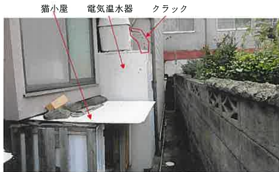
外壁の損傷状況
