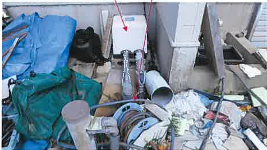
井戸ポンプ 井戸
